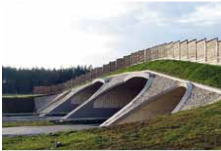
Przejście górne dla zwierząt – autostrada A2; źródło: http://www.gddkia.gov.pl/pl/595/dzialania-ograniczajace-negatywny-wplyw-drog-na-srodowisko-w-fazie-eksploatacji
