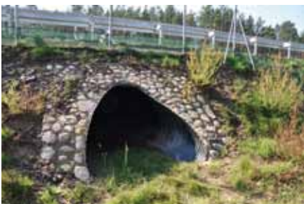
Tunel dla gadów i płazów – przejście dolne; źródło: http://autostrada-a2.pl/pl/galeria/4/a2-swiecko---nowy-tomysl/25/wrzesien-pazdziernik-201
