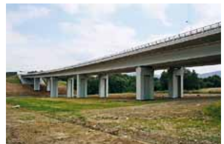
Przejście dolne pod estakadą. Zwraca się uwagę na ubogie zagospodarowanie przestrzeni pod pomostem estakady; źródło: http://pracownia.org.pl/przejscia-dla-zwierzat
