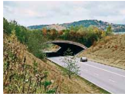
Przejście górne; źródło: http://pracownia.org.pl/przejscia-dla-zwierzat
