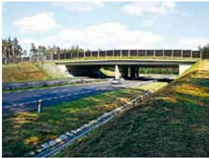
Przejście górne; źródło http://pracownia.org.pl/przejscia-dla-zwierzat
