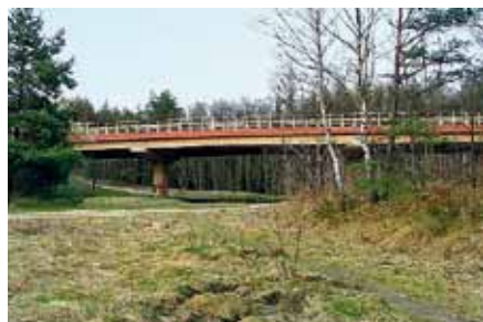
Przejście pod estakadą – przejście dolne; źródło: http://pracownia.org.pl/przejscia-dla-zwierzat
