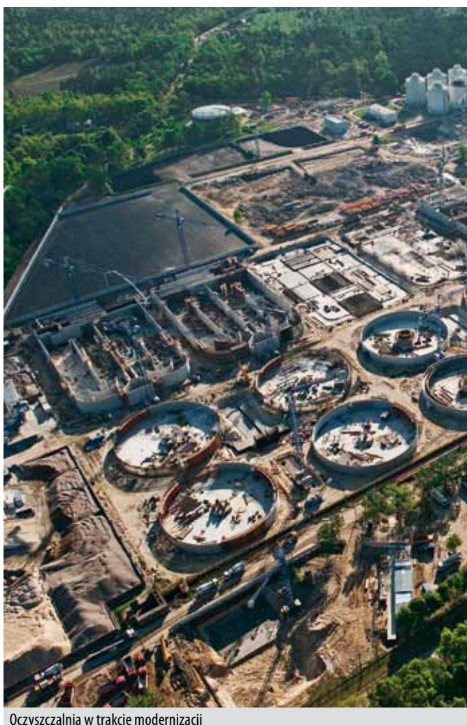
Oczyszczalnia w trakcie modernizacji
