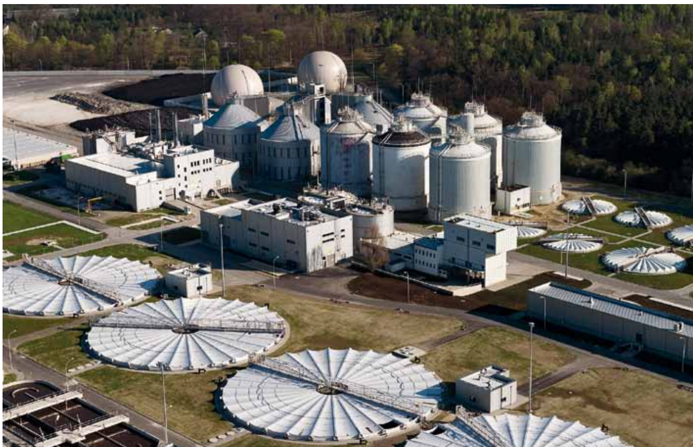
Wydzielone komory fermentacyjne, stacja zagęszczania i odwadniania osadów oraz osadniki wstępne
