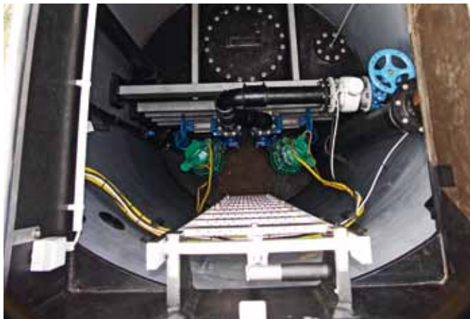
Przepompownia strefowa współpracująca z kanalizacją ciśnieniową. Wykonanie tłoczni WIL0 z pompami ustawionymi na sucho dedykowane do kanalizacji ciśnieniowej. Studnia i zbiornik z tworzywa sztucznego (PEHD), orurowanie również z PEHD lub stali kwasoodpornej gwarantuje szczelność i odporność na korozję
