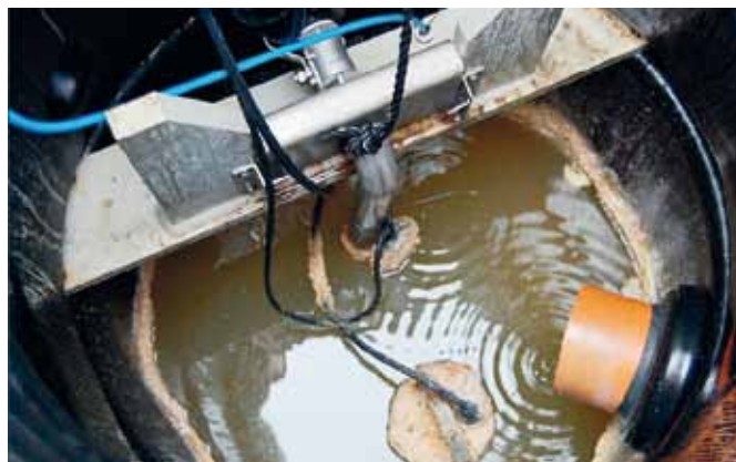
Konstrukcja zbiornika przepompowni z tworzywa sztucznego i wyposażenia stali kwasoodpornej gwarantuje szczelność i odporność na korozję
