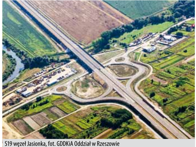
S19 węzeł Jasionka, fot. GDDKiA Oddział w Rzeszowie
