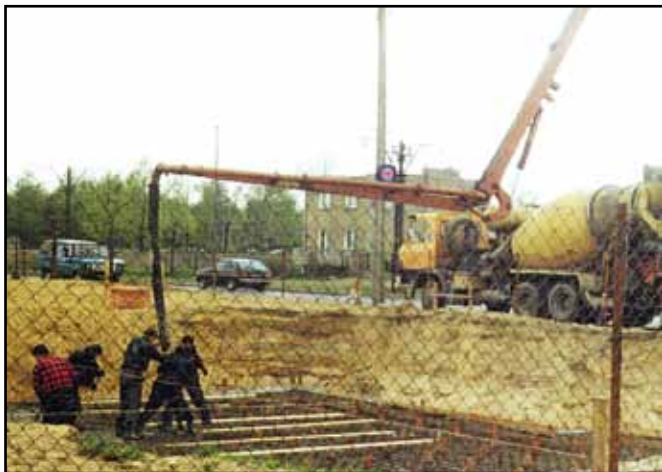
Ruszają prace na budowie nowej siedziby przy ul. Ziębickiej w Poznaniu.
