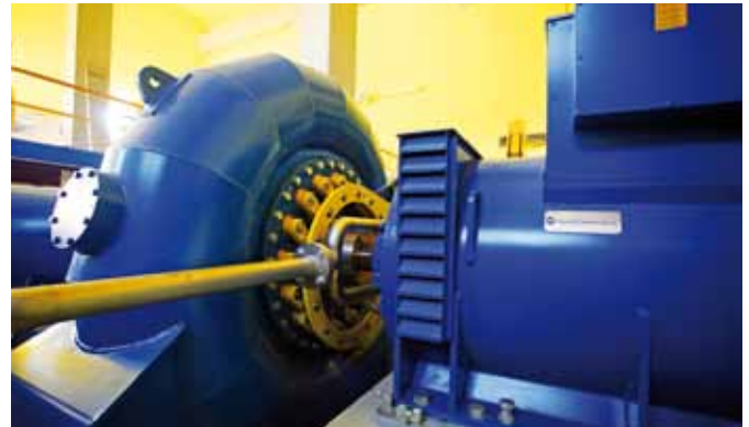
Ryc. 3. Turbina będzie produkować miesięcznie ok. 210 MWh energii, która będzie przesyłana do systemu energetycznego operatora
