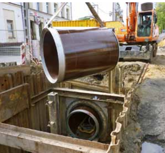
Ryc. 9. Umieszczanie rury kamionkowej DN 1400 w studni startowej (Mikołów, 2012)
