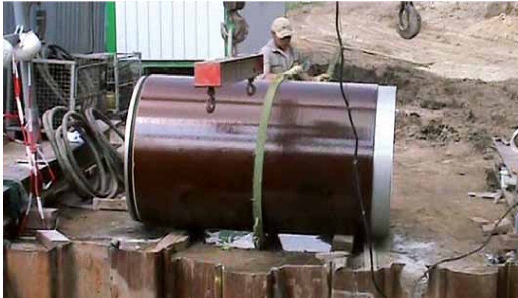
Ryc. 6. Transport rury kamionkowej DN 1000 do studni startowej 4 x 8 m (Warszawa, 2006) [4]
