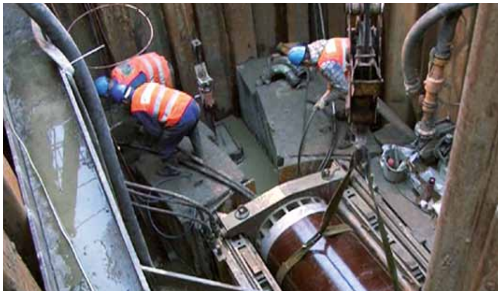
Ryc. 8. Studnia startowa 4 x 8 m (Warszawa – Pruszków, 2010) [4]
