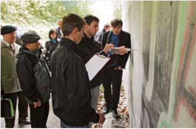
Badanie sklerometryczne z użyciem młotka Schmidta
