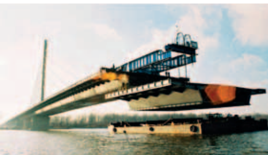
Ryc. 3. Most podwieszony przez Wisłę w Płocku – podnoszenie kolejnego segmentu
