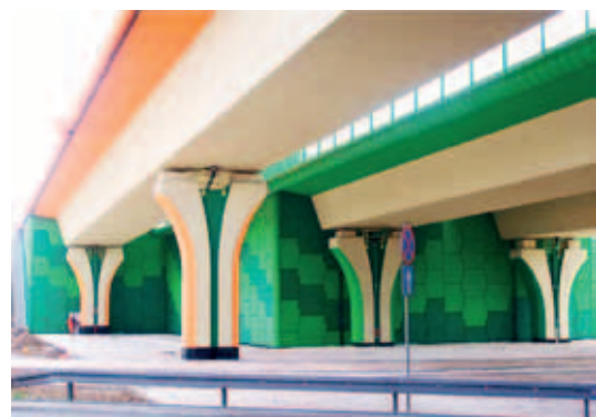
Ryc. 18. Warszawa, węzeł Marsa – przyczółki mieszane
