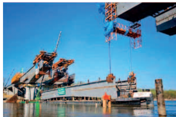
Ryc. 19. Most Północny w Warszawie – podnoszenie segmentów przęsła nurtowego
