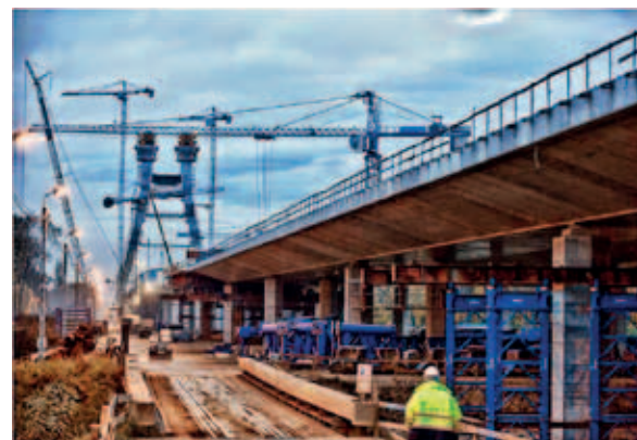
Ryc. 6. Most MA-21 w ciągu autostradowej obwodnicy Wrocławia w trakcie budowy
