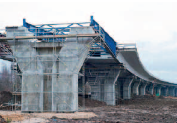
Ryc. 9. Nasuwanie estakady E2 i E3
