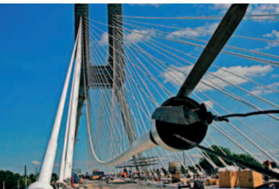
Ryc. 7. Most główny obiektu MA-21 – montaż osłony wanty
