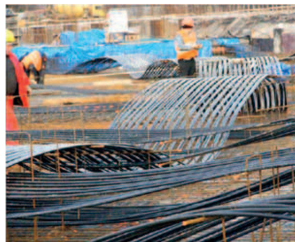
Ryc. 14. Fundament hali widowiskowo-sportowej w krakowskich Czyżynach – trasowanie kabli fundamentowych
