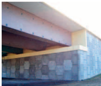
Ryc. 17. Stróża, wiadukt w ciągu zakopianki – przyczółek mieszany ze schowanymi w nasyp z gruntu zbrojonego palami
