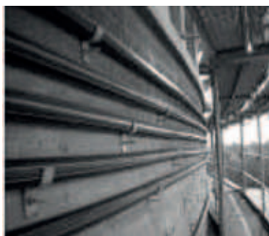
Ryc. 16. Hala Stulecia we Wrocławiu – zastosowane kable wzmacniające oraz widok hali po remoncie
