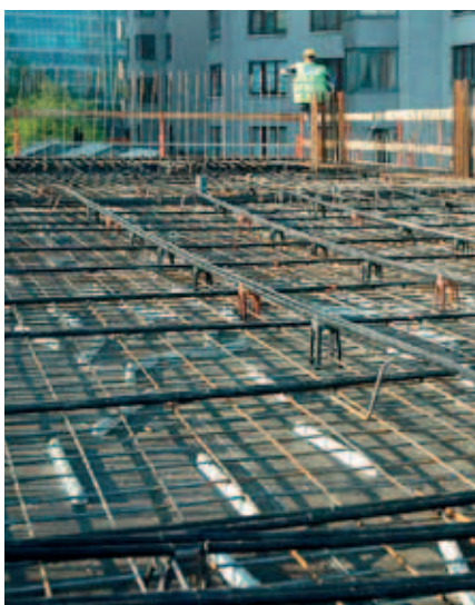
Ryc. 14. Fundament hali widowiskowo-sportowej w krakowskich Czyżynach – trasowanie kabli fundamentowych
