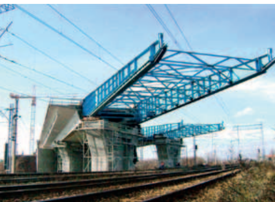
Ryc. 10. Nasuwanie estakady E4 nad torami kolejowymi
