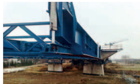
Ryc. 11. Most MA-161 – widok blachownicy dziobu montażowego przed dotarciem do kolejnej podpory
