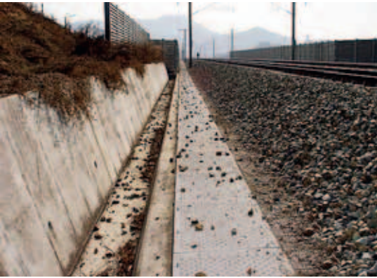
Ryc. 1. Wywiewanie ziaren podsypki podczas przejazdu pociągu z dużą prędkością, połączone często z uszkodzeniami taboru oraz powierzchni szyn, źródło: materiały Kongresu Dużych Prędkości na Tajwanie, 2009
