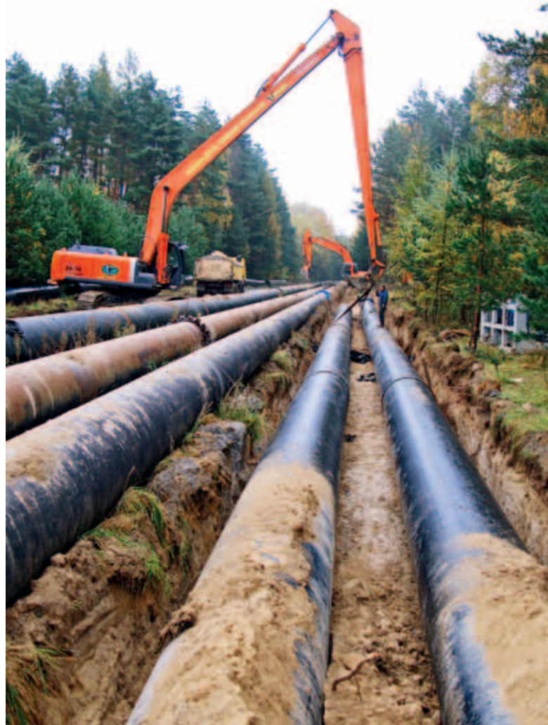
Wymiana rurociągu typu Betras na WehoPipe PE 100 DN 1000 PN 16
