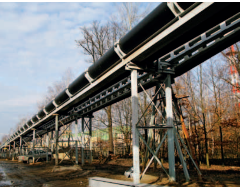
Transport odpadów poflotacyjnych rurami WehoPipe DN 900
