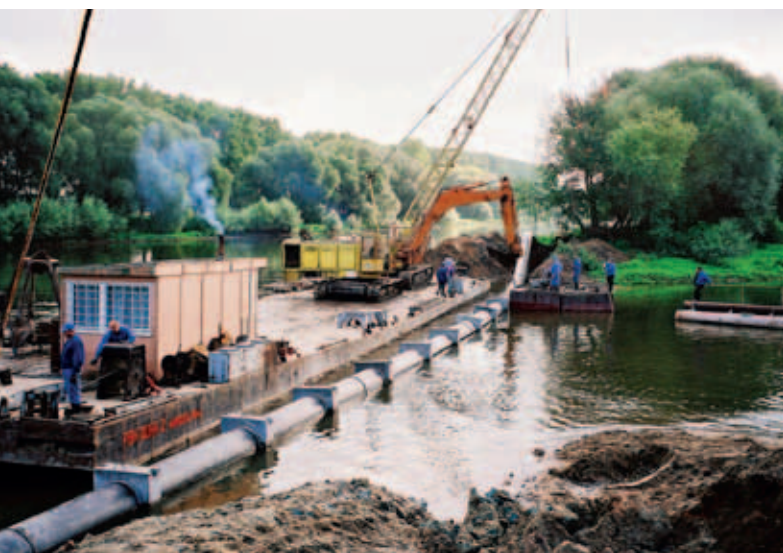
Przekroczenie odnogi Odry
