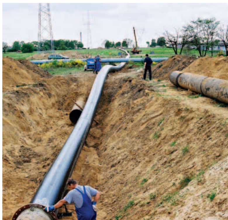
Relining – wciągnięcie rury PE 100 DN 710 do rury stalowej DN 800; długość odcinka 1100 m
