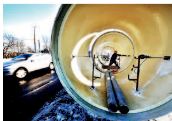
Ryc. 9. Rura przeciskowa OD 3000 mm wbudowana w ramach projektu „Czajka” [3]
