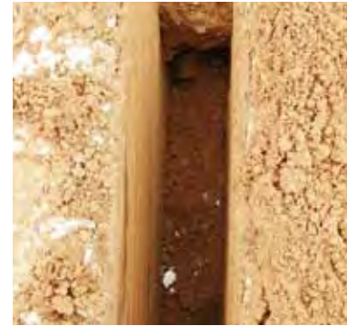
Wykop wykonany trencherem dla celów pokazowych
