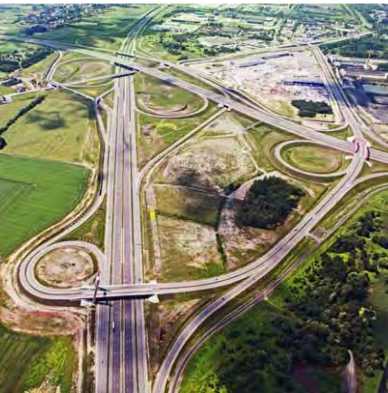
Węzeł Gliwice Sośnica skrzyżowanie autostrady A1 i A4
