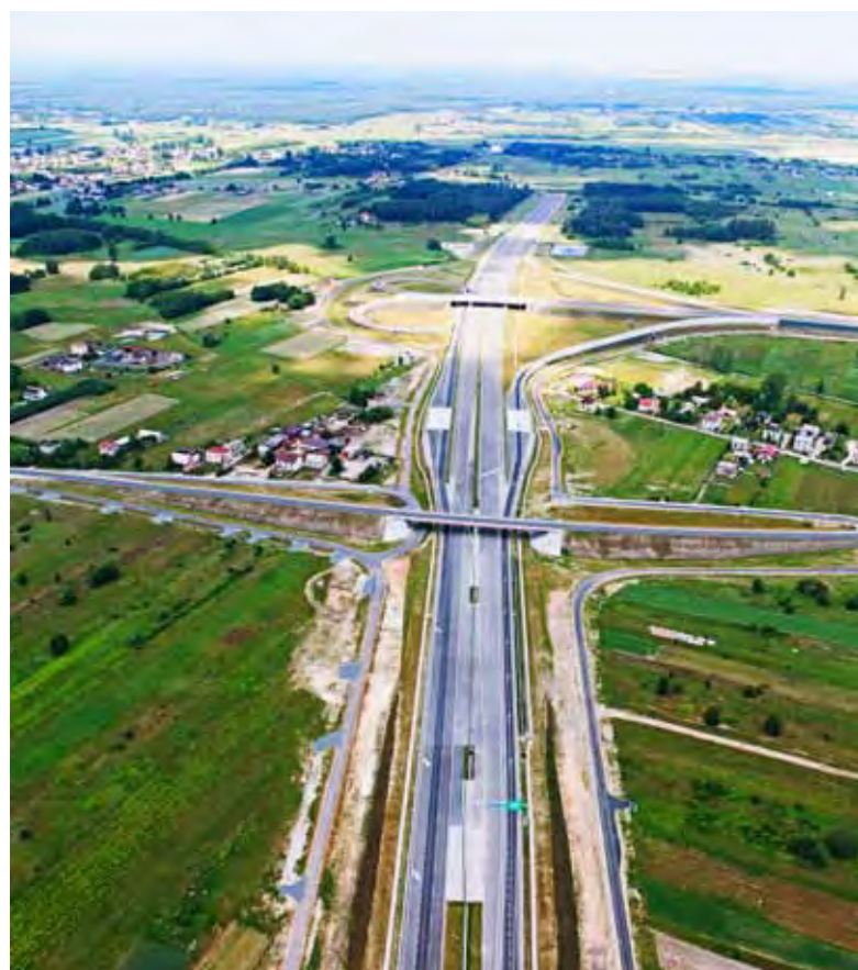
Autostrada A1 węzeł Pyrzowice wyjazd na drogę ekspresową S1
