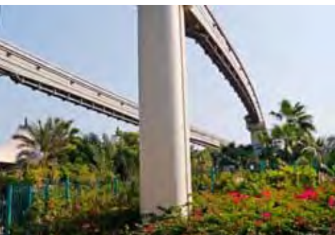
Dźwigary betonowe (szyny) kolei w obrębie falochronu wyspy, fot. K. Ryz
