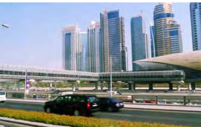
Obudowana kładka dla pieszych – dojsię do stacji metra nad dwujezdniową arterią komunikacyjną, fot. K. Ryz
