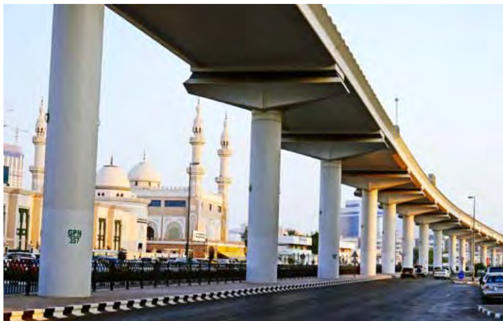
Estakada zielonej linii metra w Dubaju, fot. K. Ryz
