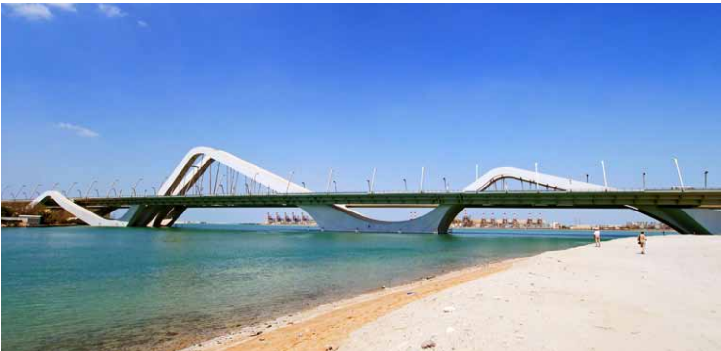
Most Zayed w Abu Dhabi – widok ogólny, fot. K. Ryż
