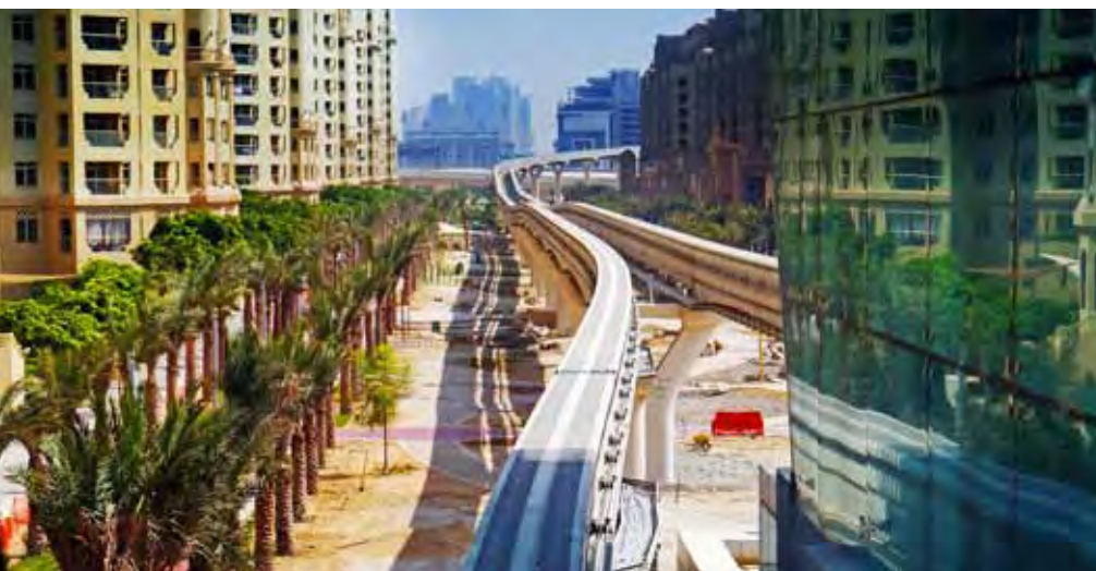
Dźwigary betonowe (szyny) kolei w obrębie zabudowanego pnia wyspy, fot. K. Ryz
