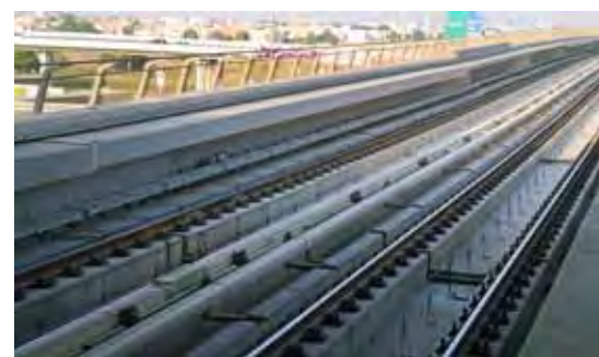
Konstrukcja torów metra na estakadzie, fot. K. Ryz
