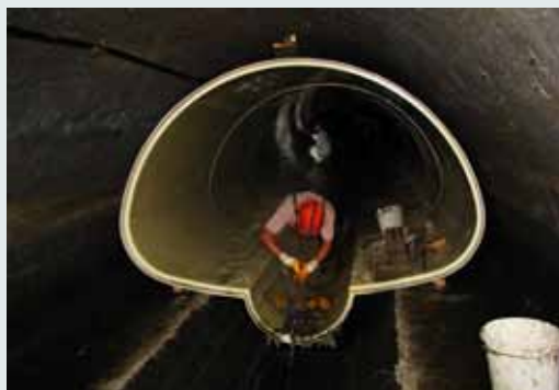
Ryc. 10. Krótkie moduły rur żywicznych GRP firmy Hobas zastosowane do bezwykopowej rehabilitacji przewodów kanalizacyjnych w Krakowie
