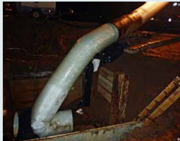
Ryc. 8. Rehabilitacja magistrali wodociągowej z zastosowaniem technologii BlueLine DN 800 w Krakowie
