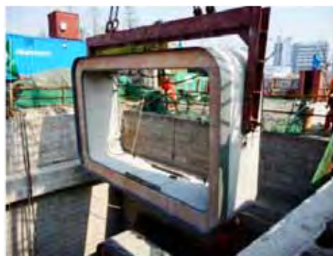
Ryc. 6. Opuszczanie kolejnej sekcji skrzyni [1]
