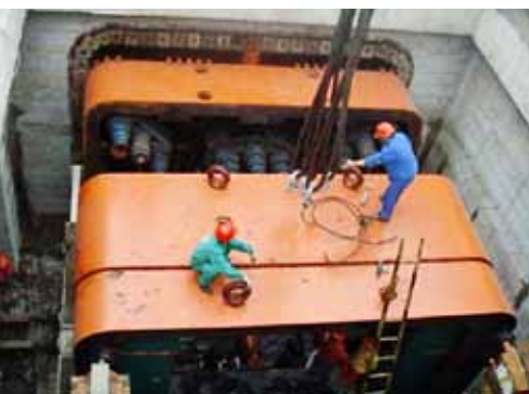
Ryc. 5. Montaż prostokątnego urządzenia tarczowego [1]
