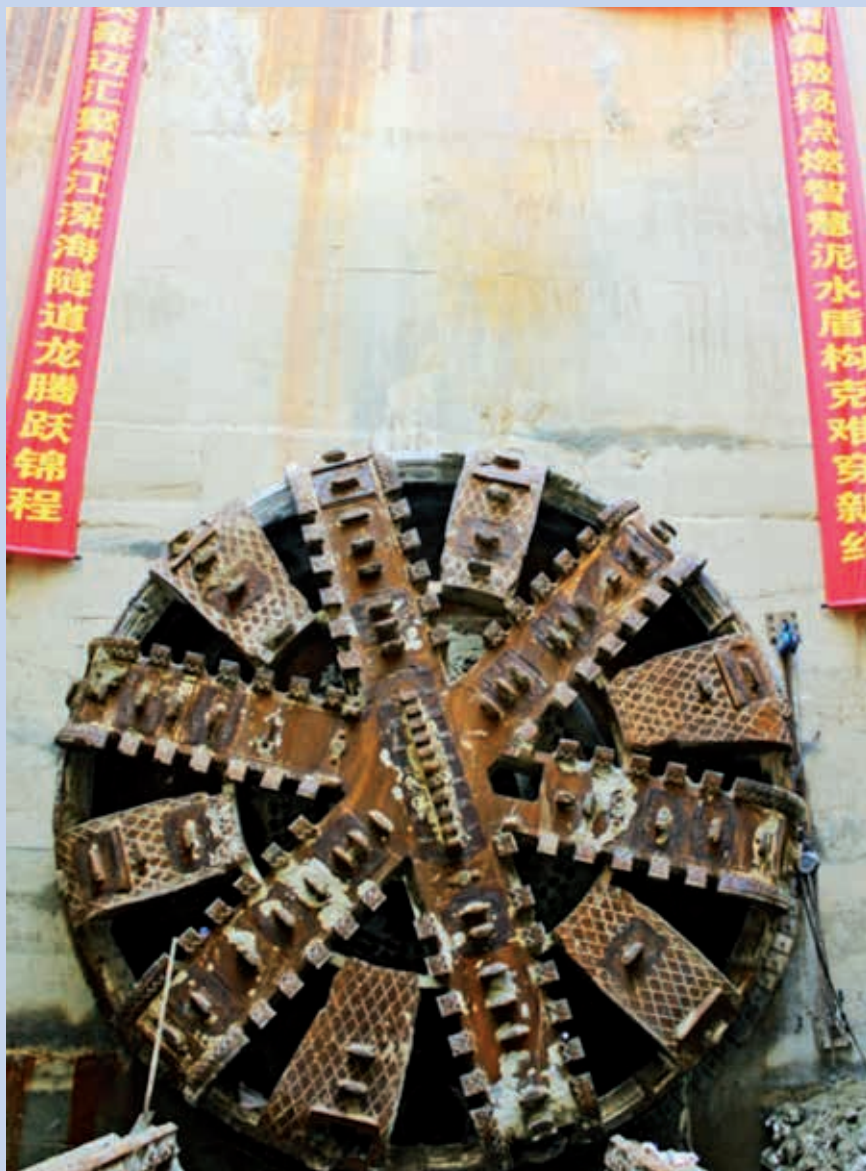
Ryc. 7. TBM firmy Robbins po przebiciu się przez ściankę w komorze końcowej [7]
