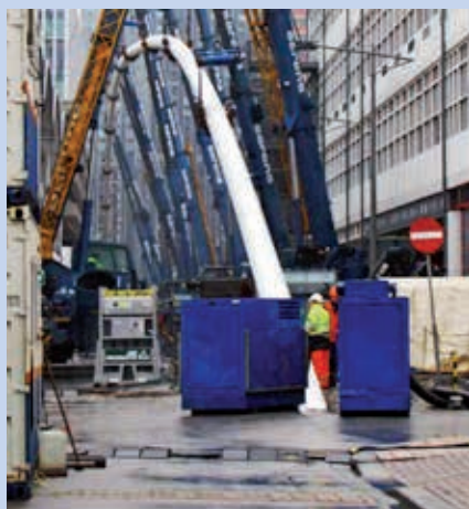
Ryc. 2. Punkt wejścia rurociągu w gęsto zabudowanej okolicy [3]
