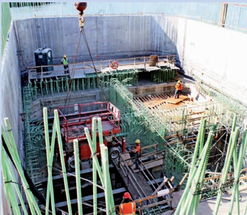
Ryc. 8. Widok kesonu, w którym zlokalizowana była komora startowa [6]
