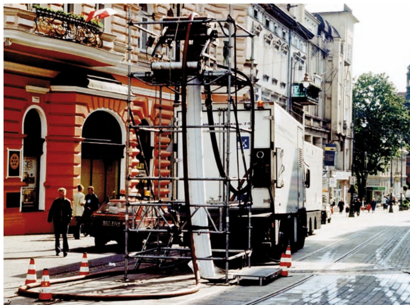
Renowacja kanalizacji, ul. Gdańska, Bydgoszcz, 2001 r.
