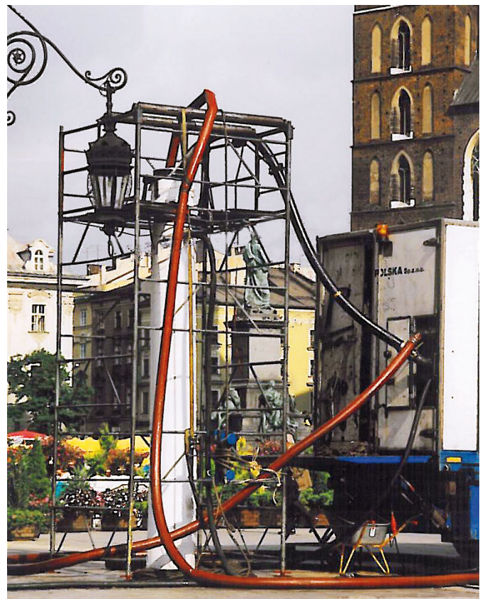
Renowacja kanalizacji, Rynek Główny, Kraków
