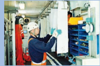
Przygotowanie długich profili kapeluszkowych do nasączenia i instalacji
