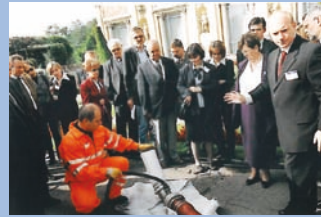
Pokaz technologii renowacji rur spustowych w Muzeum Pałacu w Wilanowie
