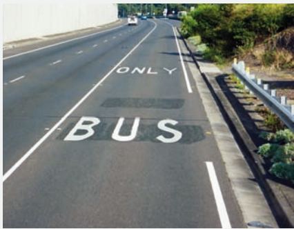
Ryc. 4. Uprzywilejowany pas dla autobusów na autostradzie pozamiejscowej, niespotykany w krajach europejskich. Pomysł zbliżony do preferowanego w USA szybkiego pasa ruchu na niektórych autostradach dla pojazdów co najmniej z dwiema osobami
