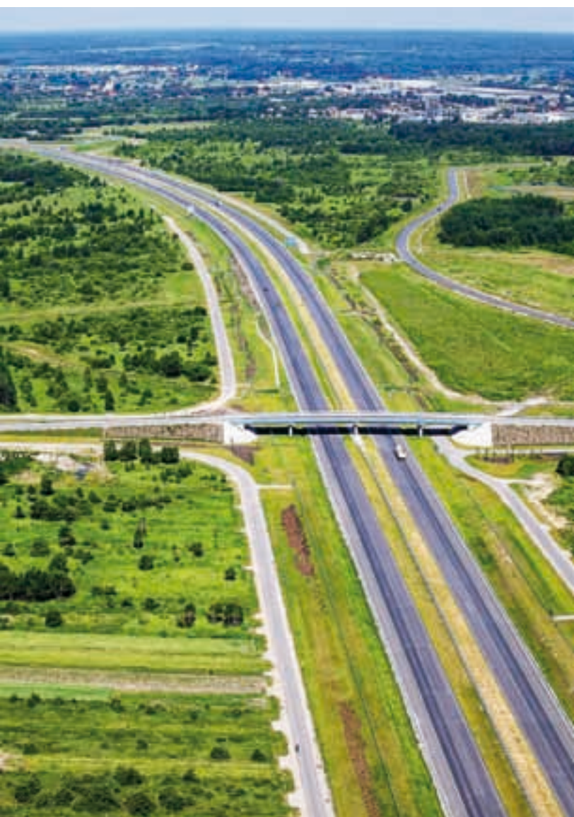
Autostrada A4 Dębica – Rzeszów
