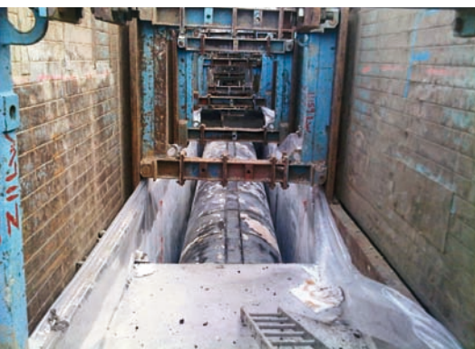
Obudowa liniowa odporna na betonowanie
