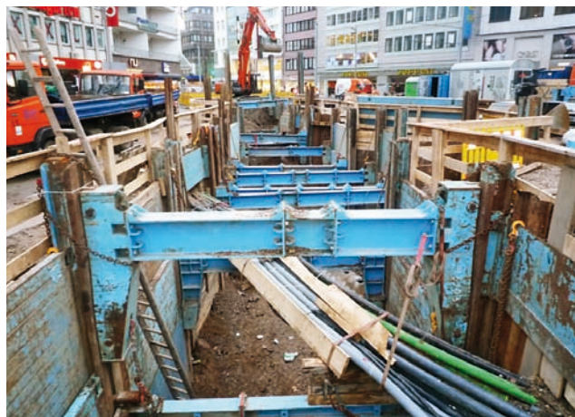
Miejska obudowa liniowa – idealna do obudowywania poprzecznych instalacji
