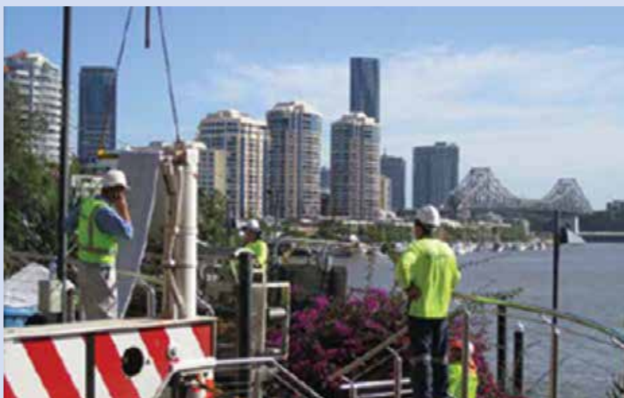
Ryc. 1. Załoga odnawiająca kolektor kanalizacyjny w Brisbane [1]
