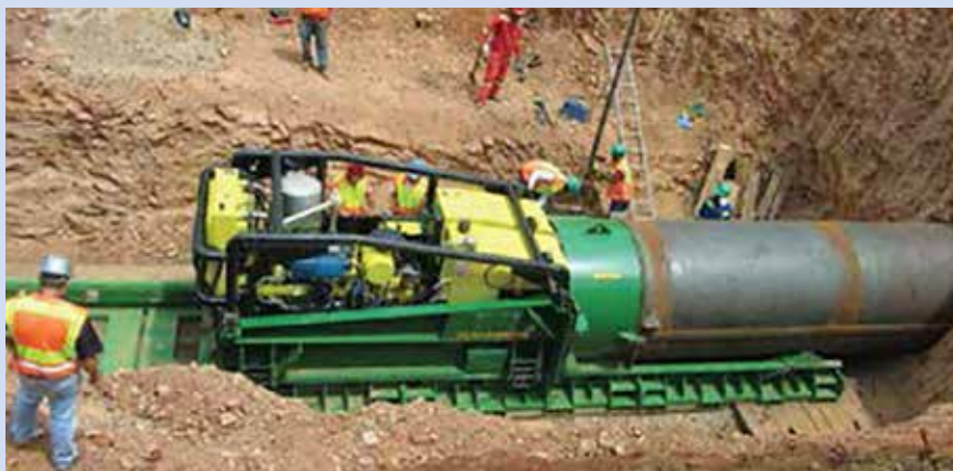
Ryc. 2. Załoga wykonująca przecisk hydrauliczny pipe jacking w RPA [1]
