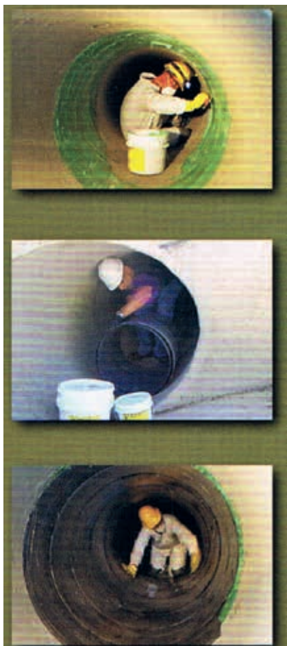
Ryc. 4. Tkanina węglowa w odnowie przewodów kanalizacyjnych
