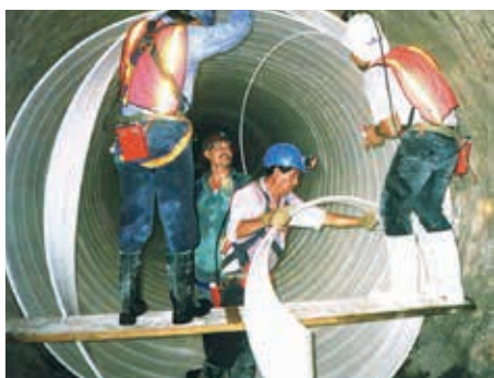
Ryc. 1. Montaż tasiemki renowacyjnej
