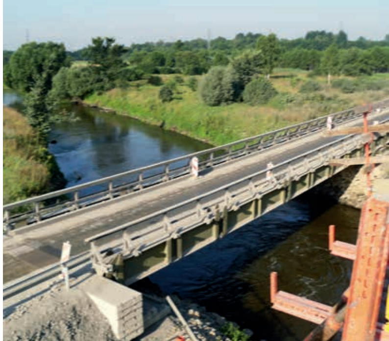
Tymczasowa przeprawa obok budowanego mostu w Chełmku
