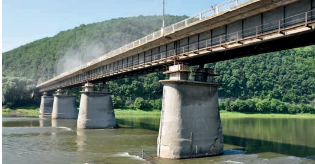
Ryc. 24. Stalowy most zespolony przez Dniestr w Zaleszczykach
