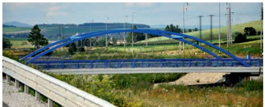
Ryc. 38. Stalowy most łukowy nad kanałem koło autostrady Koszyce – Poprad
