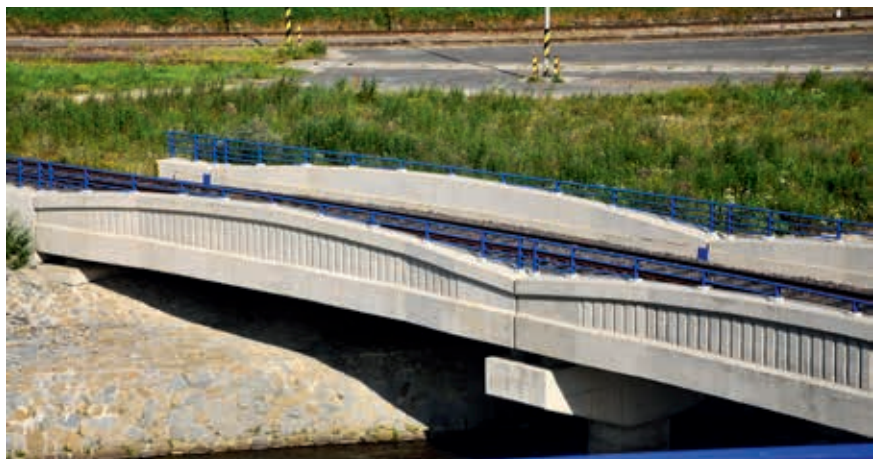
Ryc. 39. Żelbetowy most kolejowy nad kanałem wzdłuż autostrady Koszyce – Poprad
