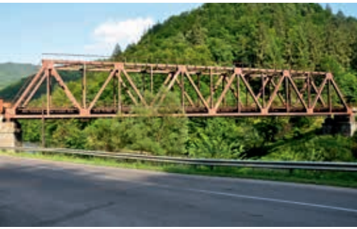
Ryc. 31. Stalowy most kolejowy przez Cisę w Ługach
