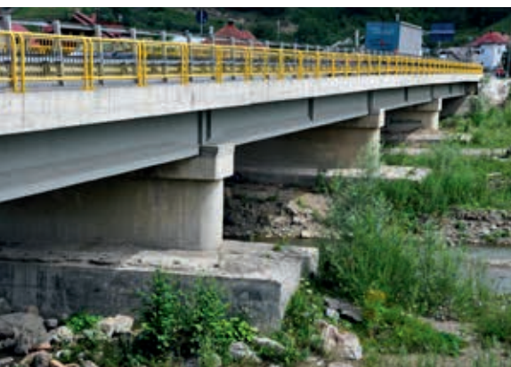
Ryc. 17. Betonowy sprężony most belkowy przez Mołdowę w Varnie koło Mołdovița
