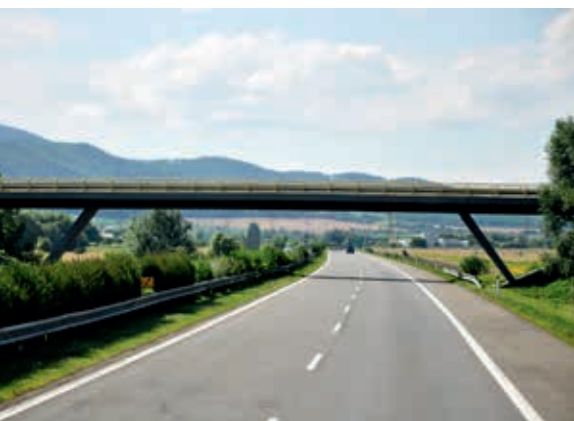
Ryc. 37. Betonowy, sprężony wiadukt rozporowy nad autostradą Koszyce – Poprad
