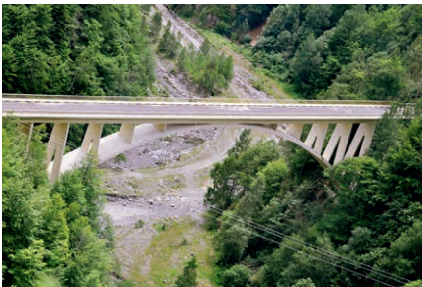
Ryc. 6. Żelbetowy most łukowy I przez Ardżesz na Trasie Transfagaraskiej
