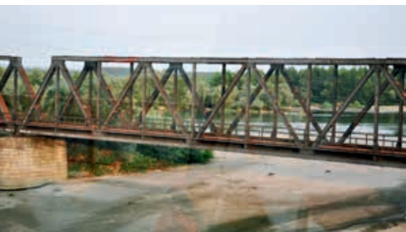
Ryc. 2. Kratownicowy most kolejowy przez rzekę Jiu w pobliżu Krajowej
