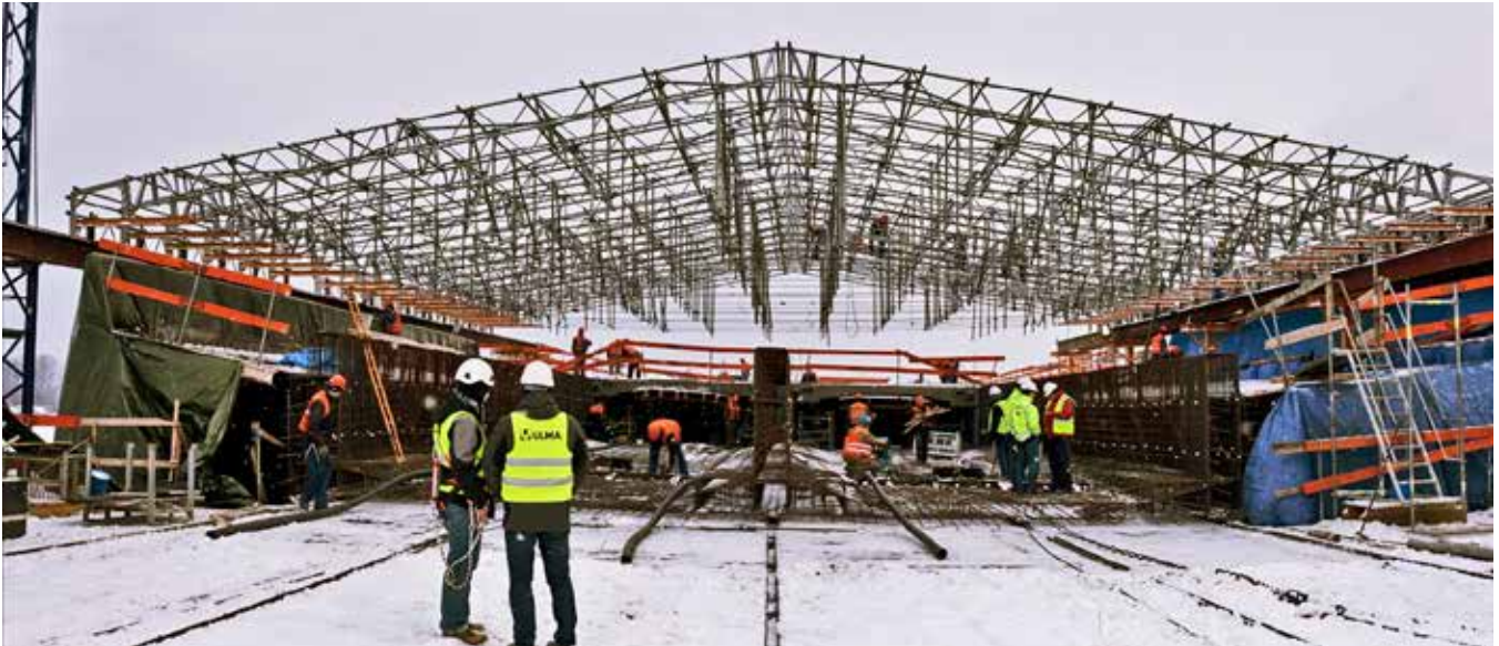
Namiot nad stanowiskiem prefabrykacji na estakadzie E-118 w ciągu A4
