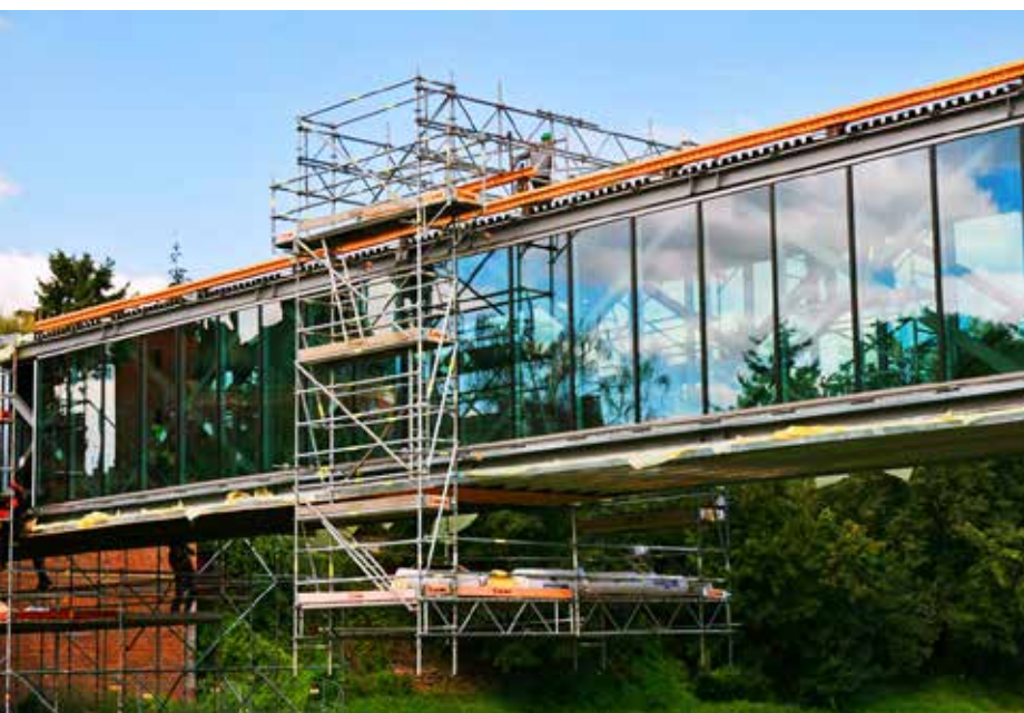
Wózek jezdny na kładce do „Bramy Poznania”
