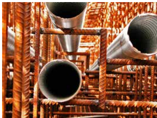
Osonki kanałów kablowych pomiędzy zbrojeniem belki
