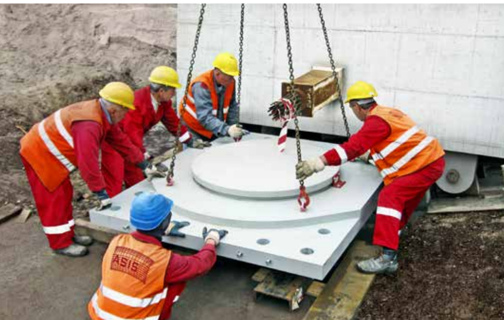
Montaż łożyska soczewkowego o nośności 80 MN pod pylonem wiaduktu na węźle Sośnica
