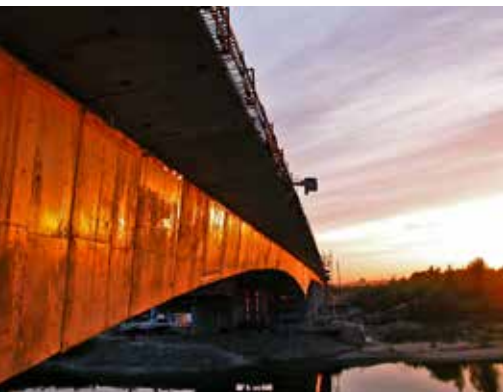
Most w ciągu A4 przez Dunajec, budowany metoda nawisową
