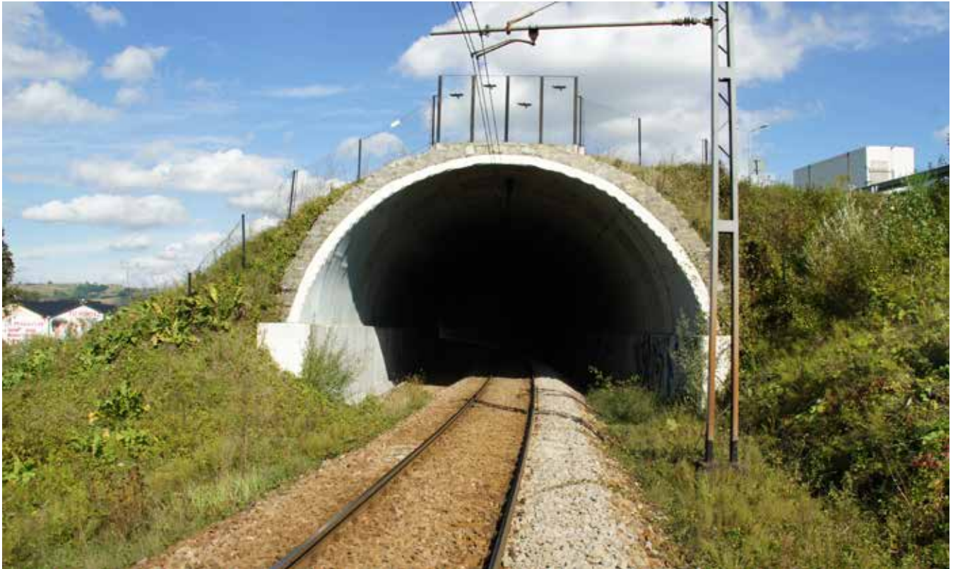
Ryc. 4. Kolejowa konstrukcja gruntowo-powłokowa na południu Polski, fot. A. Wysokowski
