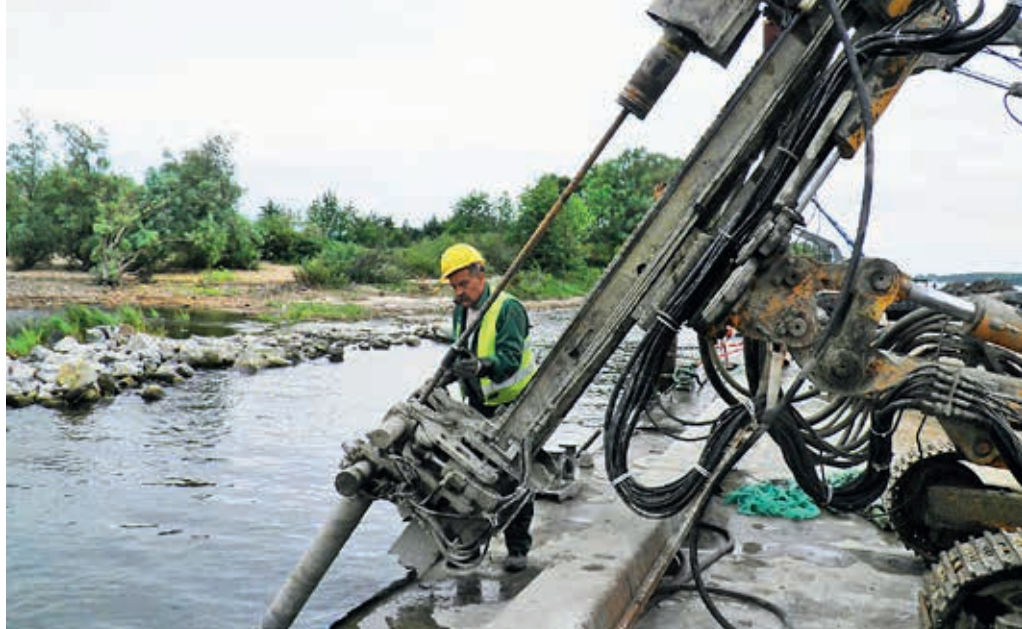
Kotwienie elementów nabrzeża (kotwie jednopretowe pod wodą), Świbno – ujście Wisły do Zatoki Gdańskiej
