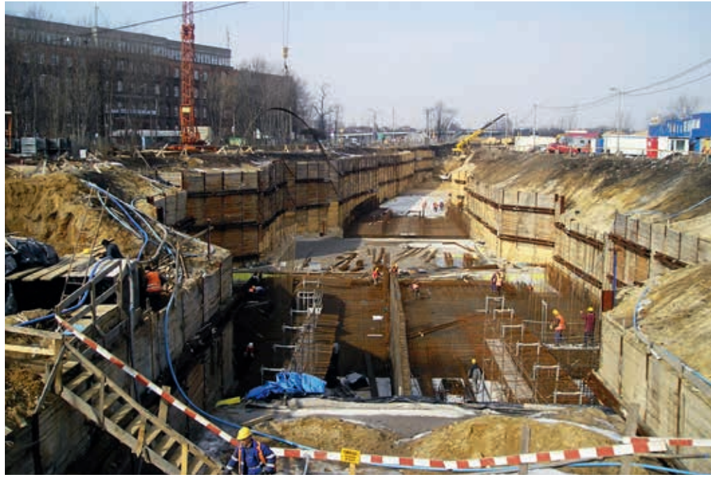
Ściana berlińska obudowy wykopu pod tunel tramwajowy przy dworcu kolejowym w Krakowie
