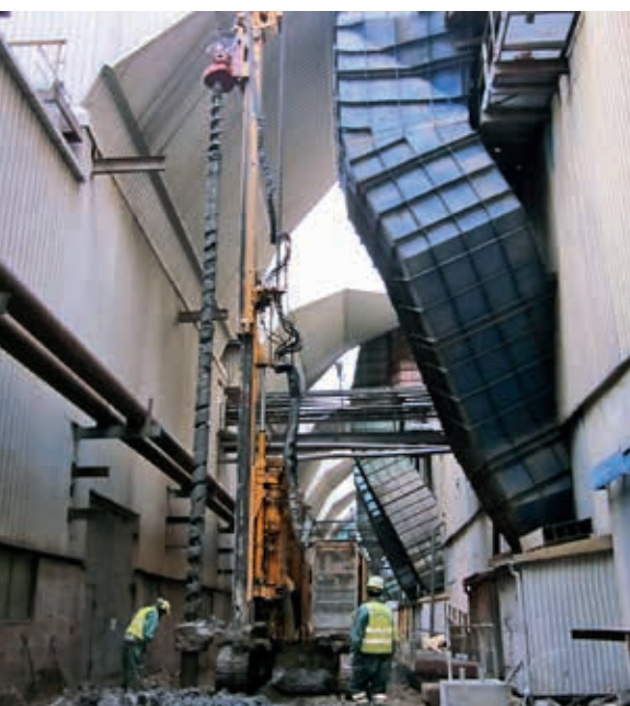
Mikropale pod fundamenty części blokowej instalacji odzotowania spalin – Elektrownia Połaniec
