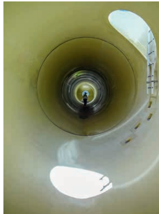
Jedna z nitek rurociągu widziana od wewnątrz
