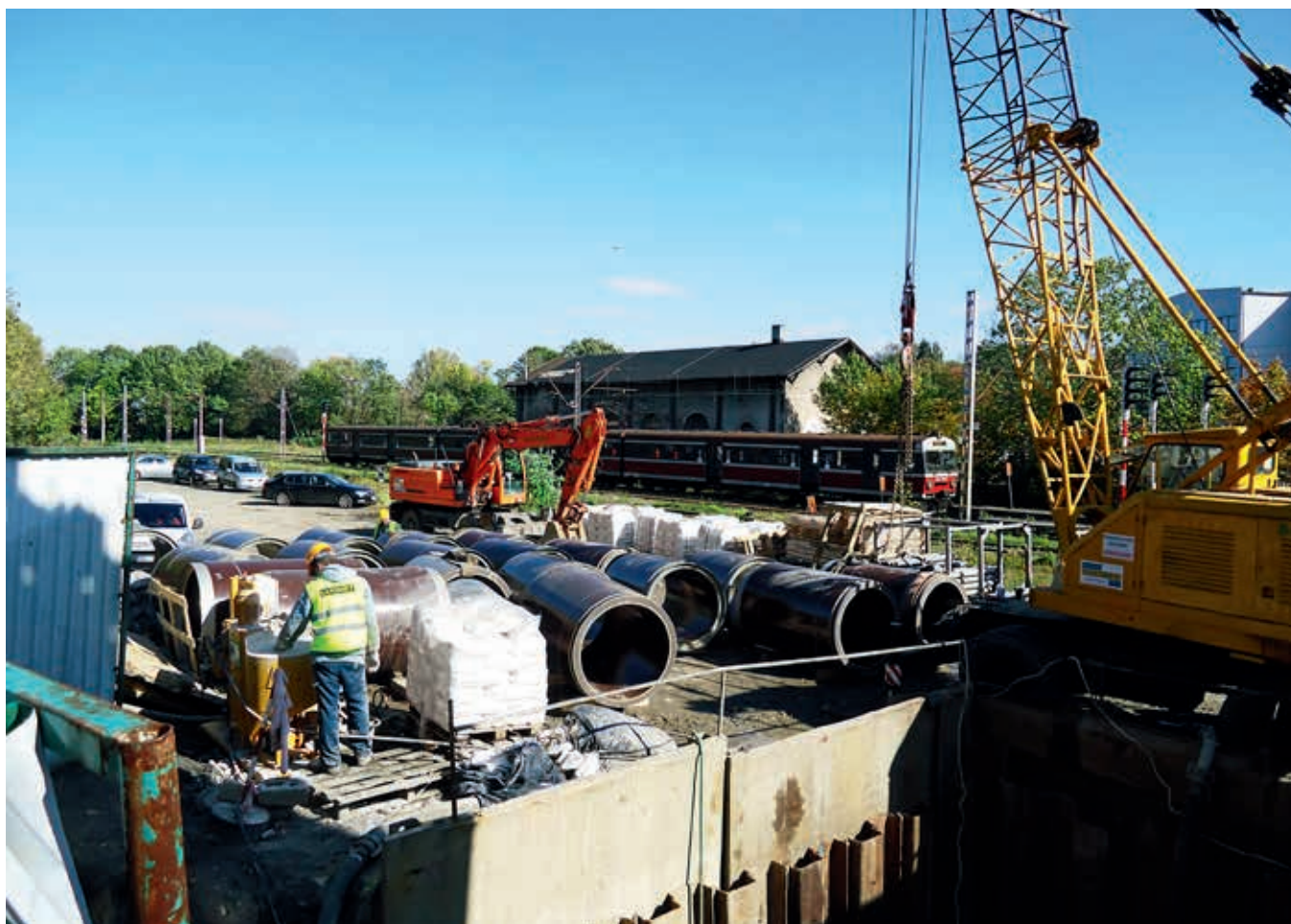
Ryc. 3. Plac budowy z rurami DN 1400 mm
