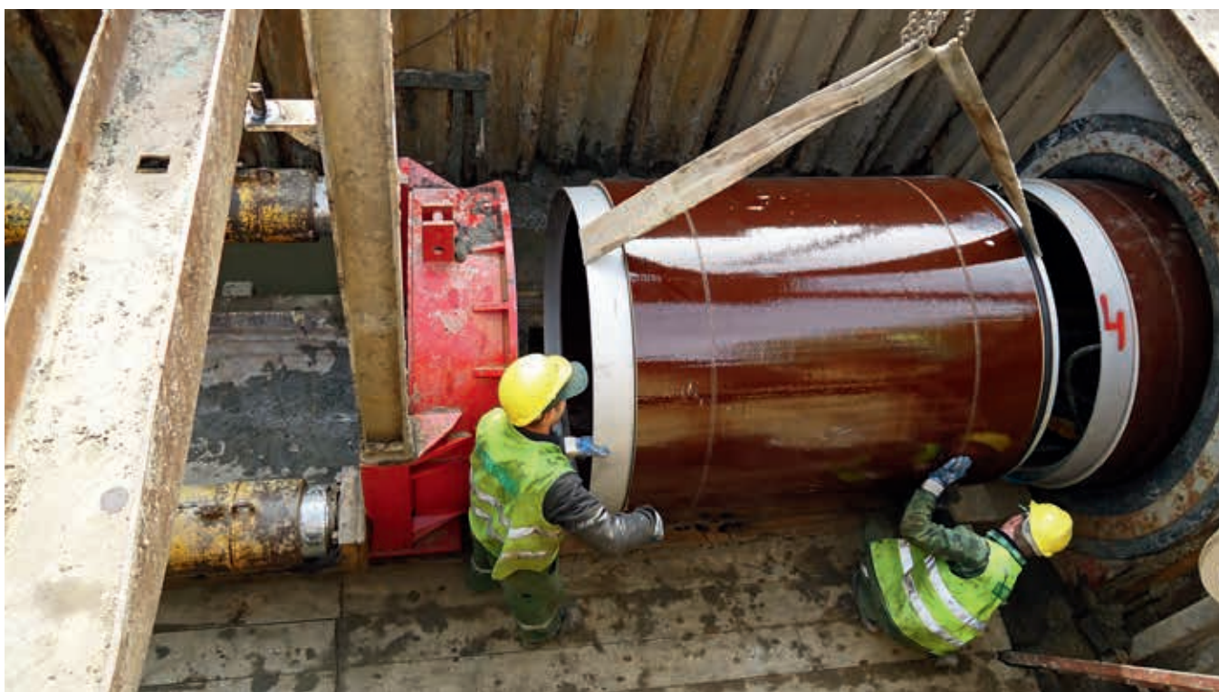
Ryc. 2. Komora startowa z rurą DN 1400 mm
