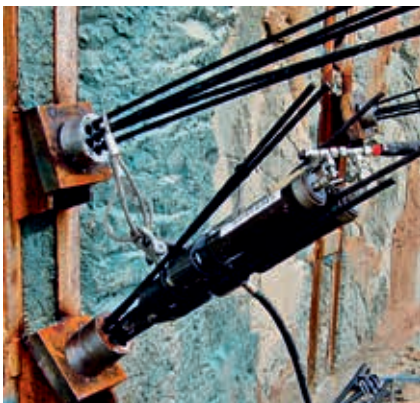
Demontaż kotew gruntowych – typ CR
