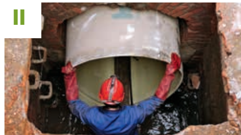
HOBAS System Polska Sp. z o.o., Renowacja kolektora we Wrocławiu
