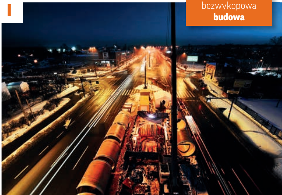
HOBAS System Polska Sp. z o.o., Kolektor odprowadzający do Oczyszczalni Ścieków „Czajka”
