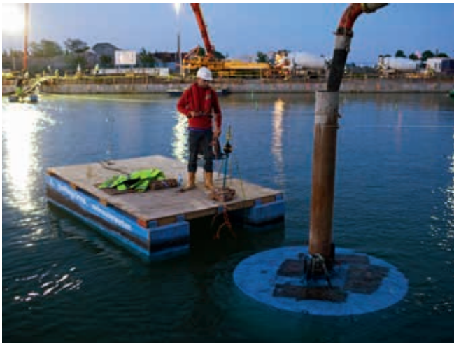
Prace przy wykonaniu korka betonowego w wykopie, fot. R. Jocher, Muzeum II Wojny Światowej w Gdańsku
