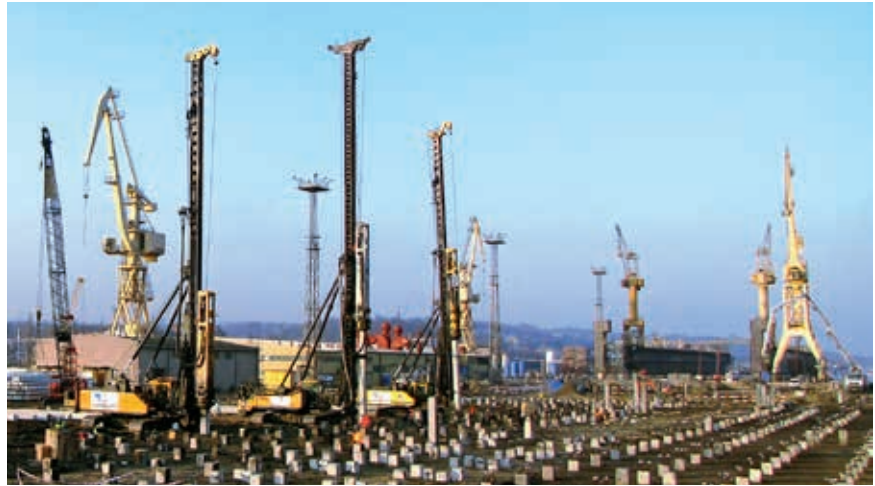
Wykonywanie żelbetowych pali prefabrykowanych, fot. Aarsleff Sp. z o.o.
