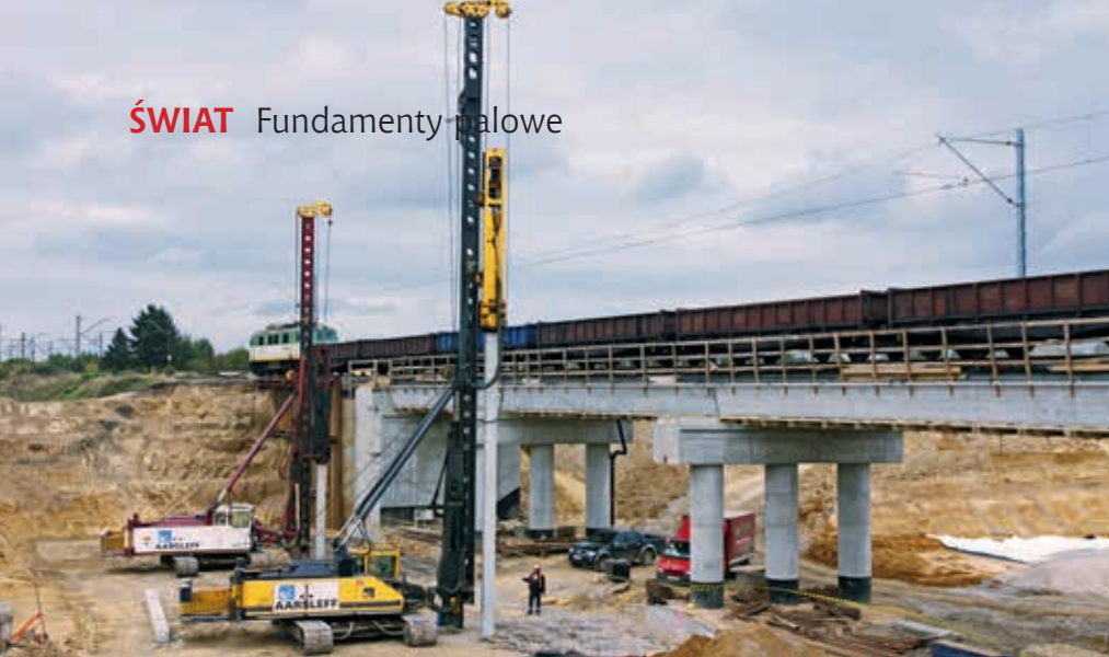
Wykonywanie żelbetowych pali prefabrykowanych, fot. Aarsleff Sp. z o.o.
