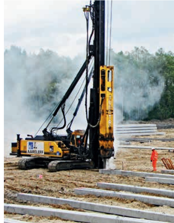
Wykonywanie żelbetowych pali prefabrykowanych, fot. Aarsleff Sp. z o.o.
