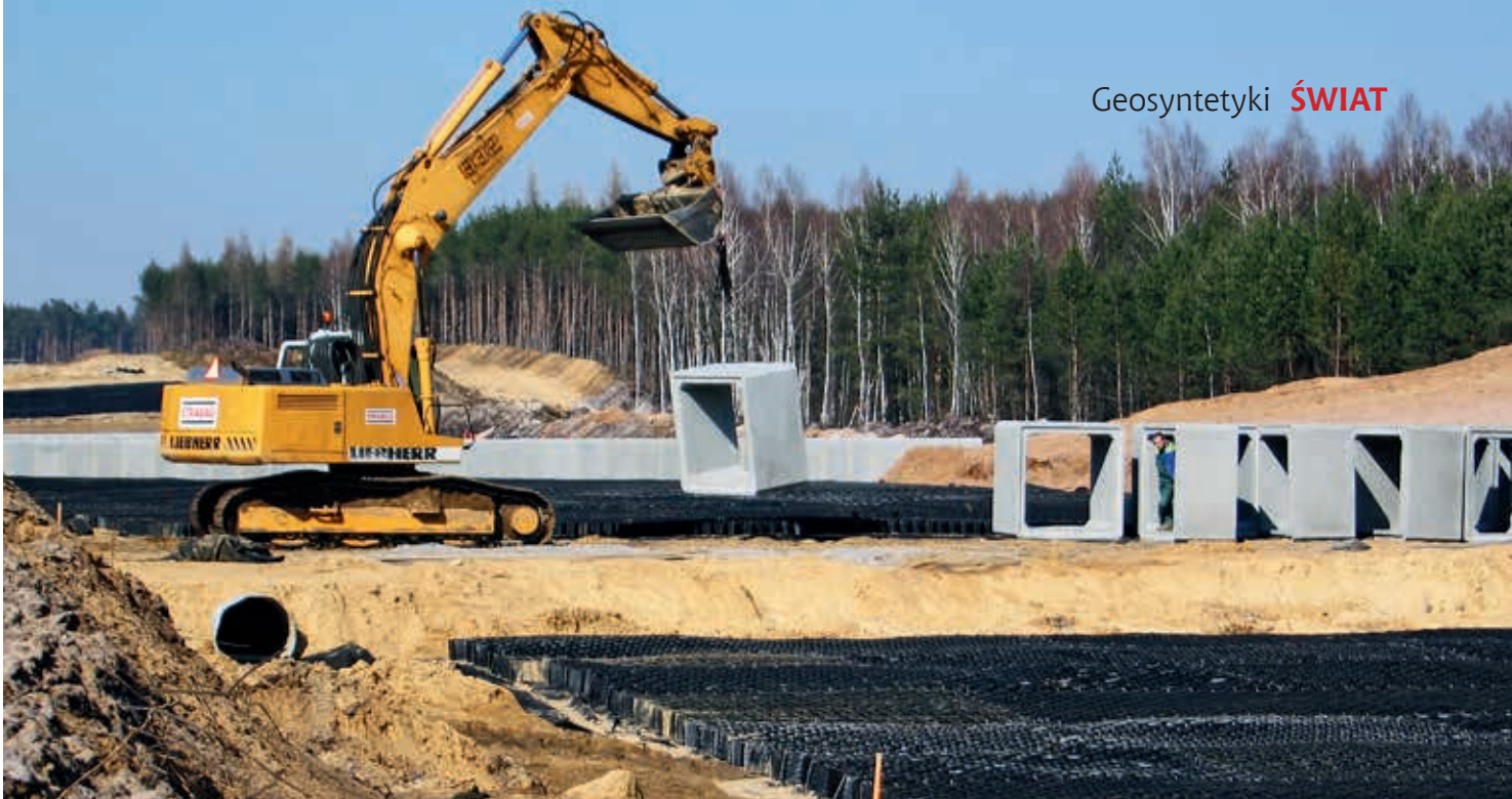
Autostrada A1 odcinek Bełk – Świerklany, fot. Geo Globe Polska
