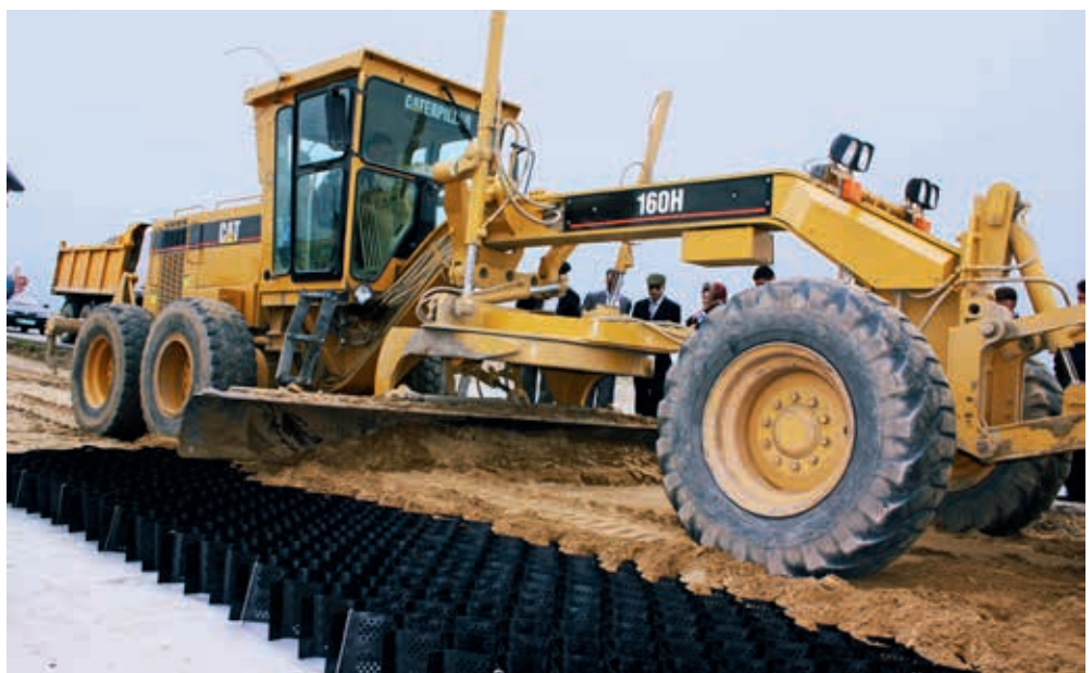
Budowa autostrady, fot. Geo Globe Polska
