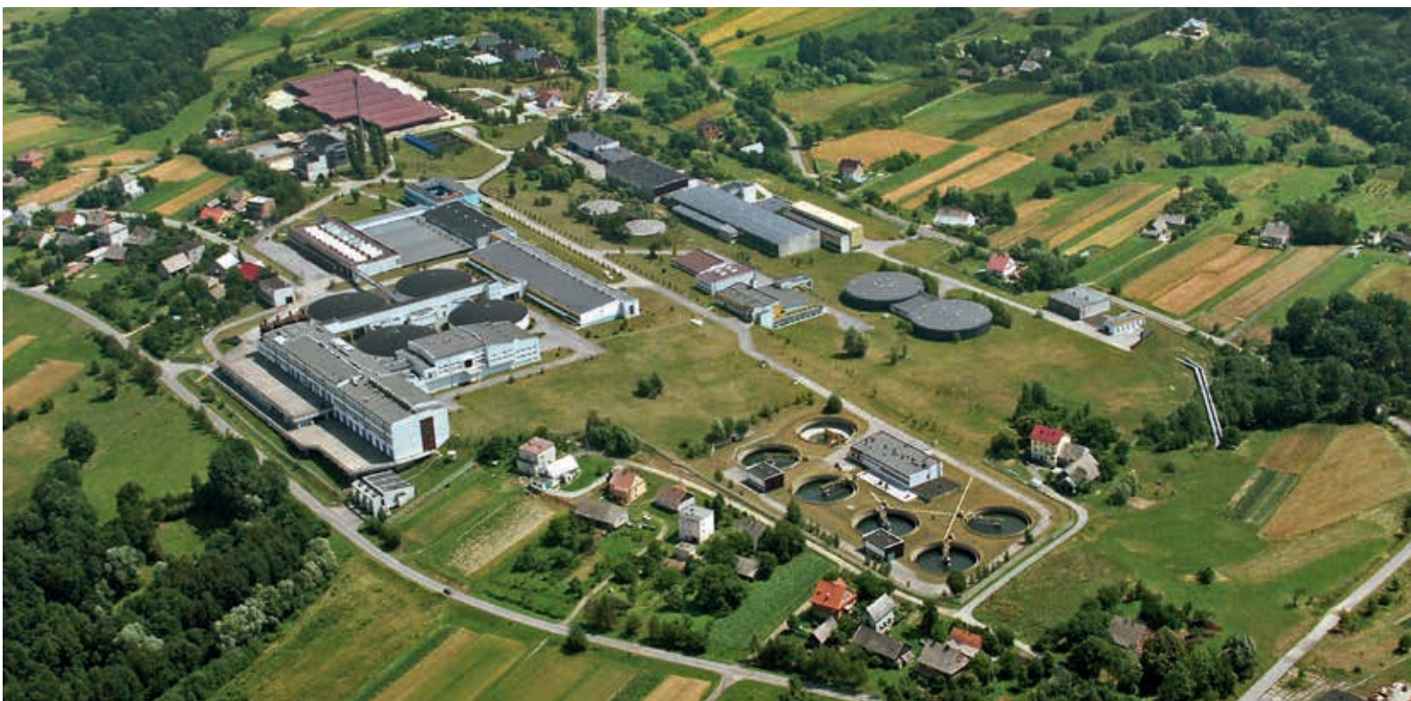
Zakład Uzdatniania Wody Raba
