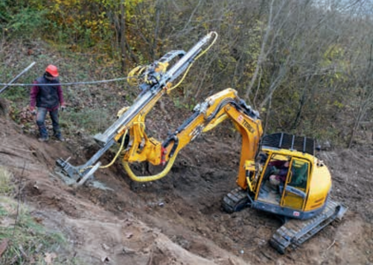
Osuwiska na wybrzeżu Bałtyku - zabezpieczenie osuwiska na klifie, Jarosławiec, fot. Titan Polska Sp. z o.o.
