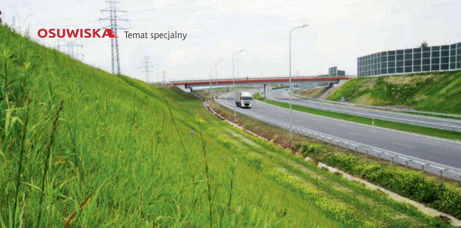
Zabezpieczenie skarpy na autostradzie A1 Piekary Śląskie - Maciejów, fot. Geobrugg Partner in Poland
