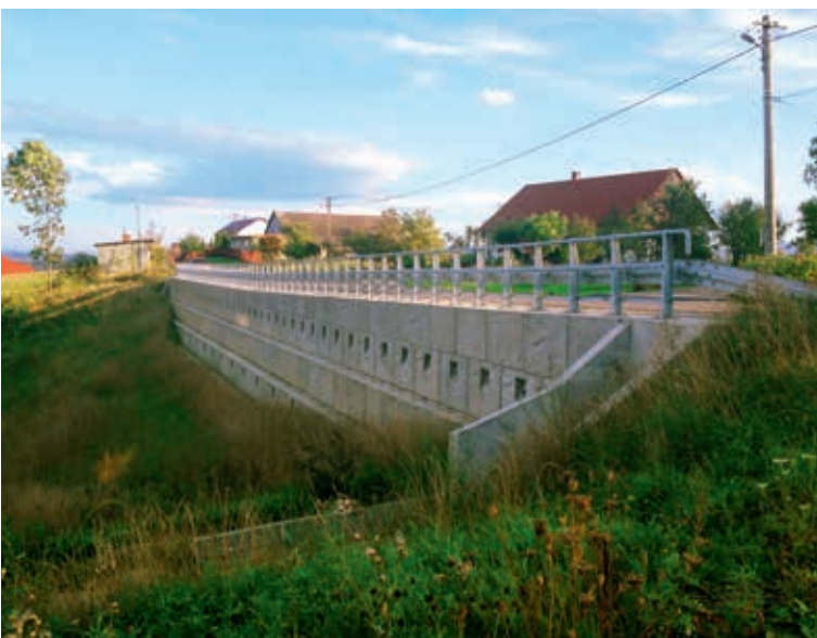
Zabezpieczenie osuwiska z całkowitym odtworzeniem terenu – w tym przypadku drogi wraz z poboczem, fot. Titan Polska Sp. z o.o.
