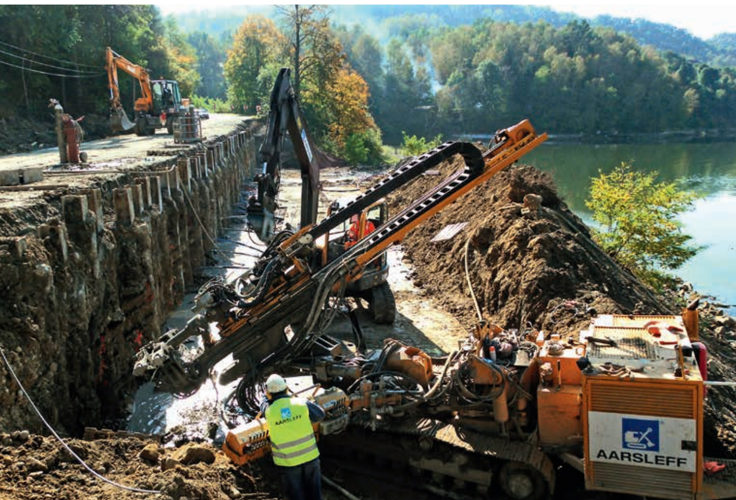
Stabilizacja osuwiska w Lipiu, fot. Aarsleff Sp. z o.o.
