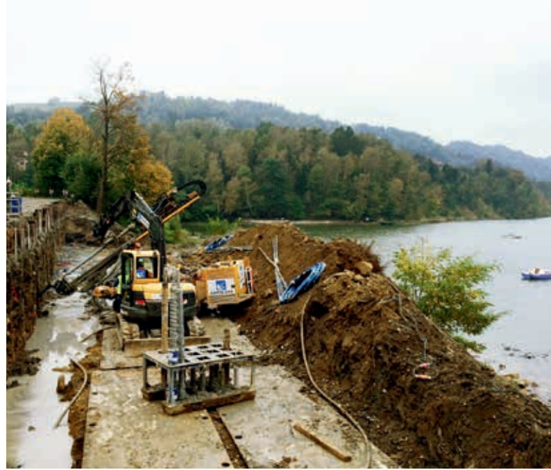
Zabezpieczanie czynnego osuwiska w Lipiu, fot. Aarsleff Sp. z o.o.
