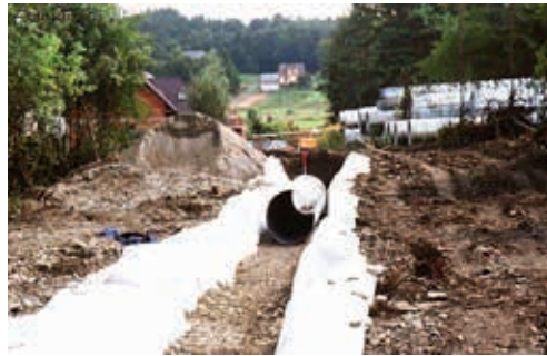
Odbudowa osuwiska Falkowa – wykonanie drenażu w postaci rur HelCor® owiniętych geowłókniną
