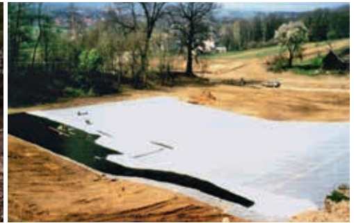
Odbudowa osuwiska Falkowa – montaż geowłókniny i geokraty
