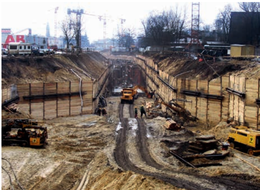
Ryc. 2. Wykop w obudowie berlińskiej – budowa tunelu szybkiego tramwaju w Krakowie, fot. Stump-Hydrobudowa Sp. z o.o.
