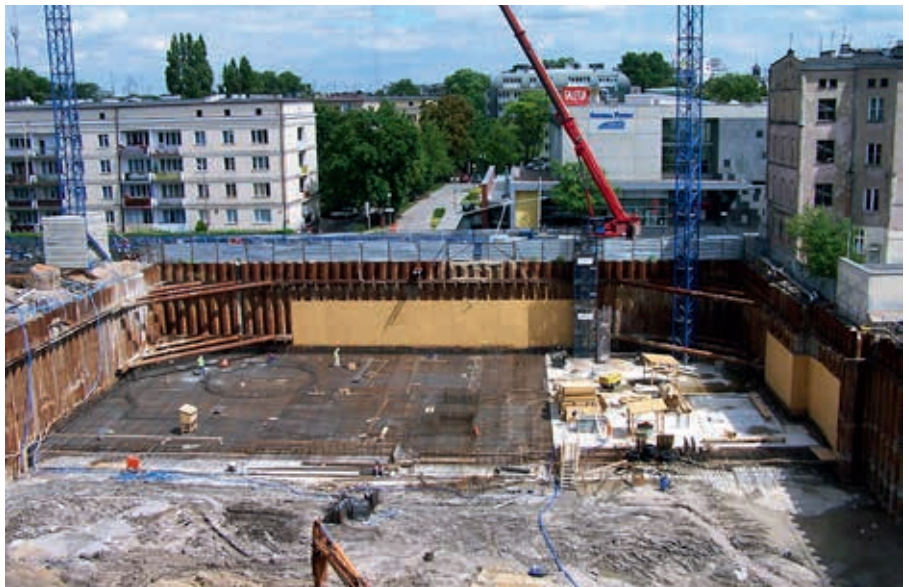
Ryc. 4. Wykop w terenie zabudowanym w obudowie z grodzic stalowych, fot. Aarslef Sp. z o.o.
