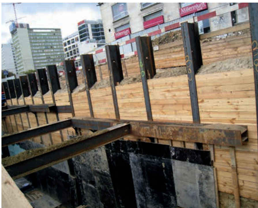
Ryc. 3. Wykop w obudowie berlińskiej – wyjście ze stacji metra w Warszawie, fot. A. Siemińska-Lewandowska
