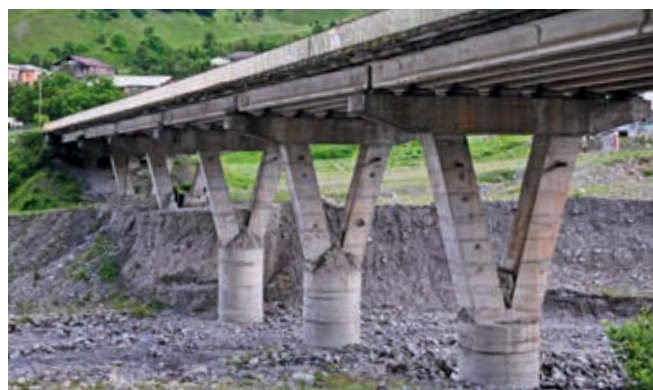
Ryc. 17. Betonowy most z belek prefabrykowanych przez rzekę Aragwi wzdłuż Gruzińskiej Drogi Wojennej, fot. K. Flaga
