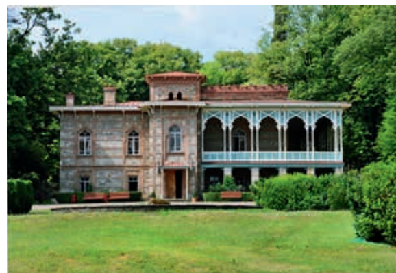
Ryc. 6. Pałac w Tsinandali z XIX w., fot. K. Flaga
