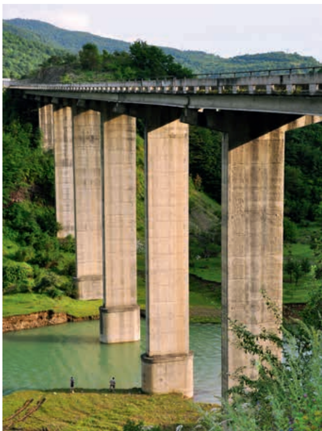
Ryc. 16. Betonowy most z belek prefabrykowanych na wysokich filarach żelbetowych w Zhinwali, fot. K. Flaga
