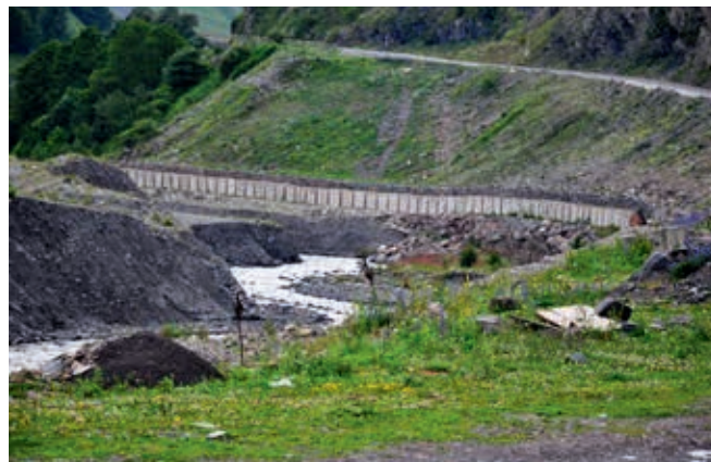
Ryc. 18. Umocnienia na Gruzińskiej Drodze Wojennej, fot. K. Flaga
