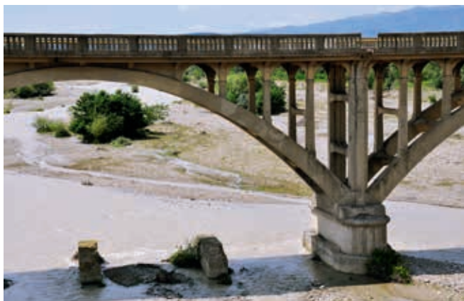
Ryc. 8. Łukowy most żelbetowy przez rzekę Iori, fot. K. Flaga
