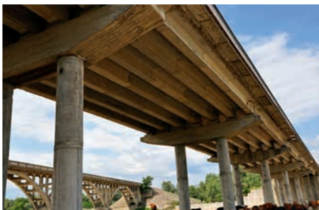
Ryc. 9. Betonowy most z belek sprężonych przez rzekę Iori, fot. K. Flaga
