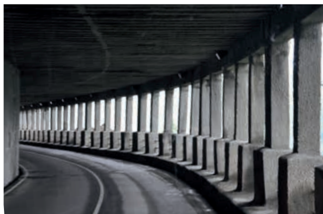
Ryc. 28. Galeria osłonowa na Gruzjińskie Drodze Wojennej, fot. K. Flaga
