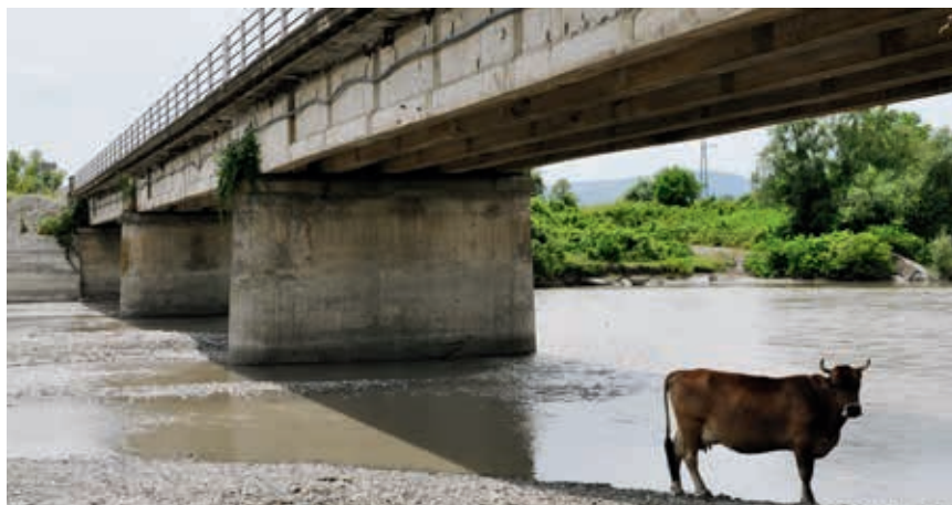
Ryc. 2. Betonowy most z belek sprężonych przez rzekę Alazani, fot. K. Flaga
