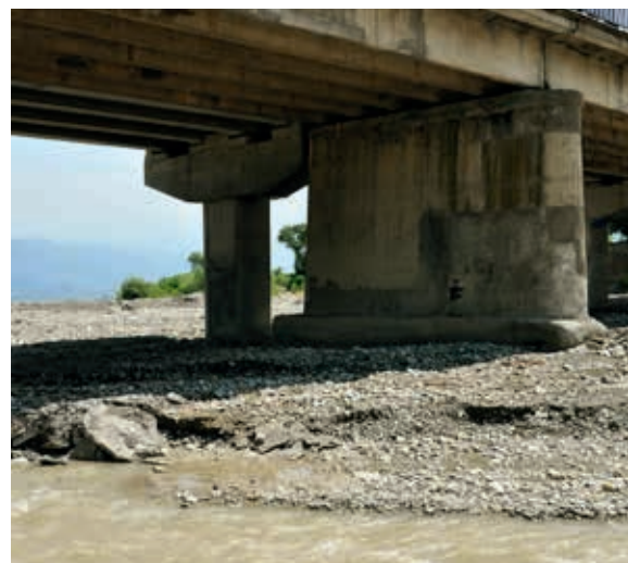
Ryc. 7. Betonowy most z belek sprężonych przez rzekę Kisisk, fot. K. Flaga
