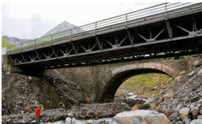
Ryc. 25. Dwa mosty na Gruzjińskie Drodze Wojennej – stalowy kratownicowy i stary kamienny, łukowy, fot. K. Flaga
