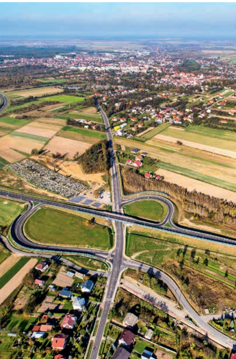
W 2013 r. oddano do użytku I etap obwodnicy Leżajska – na zdjęciu węzeł Giedlarowa
