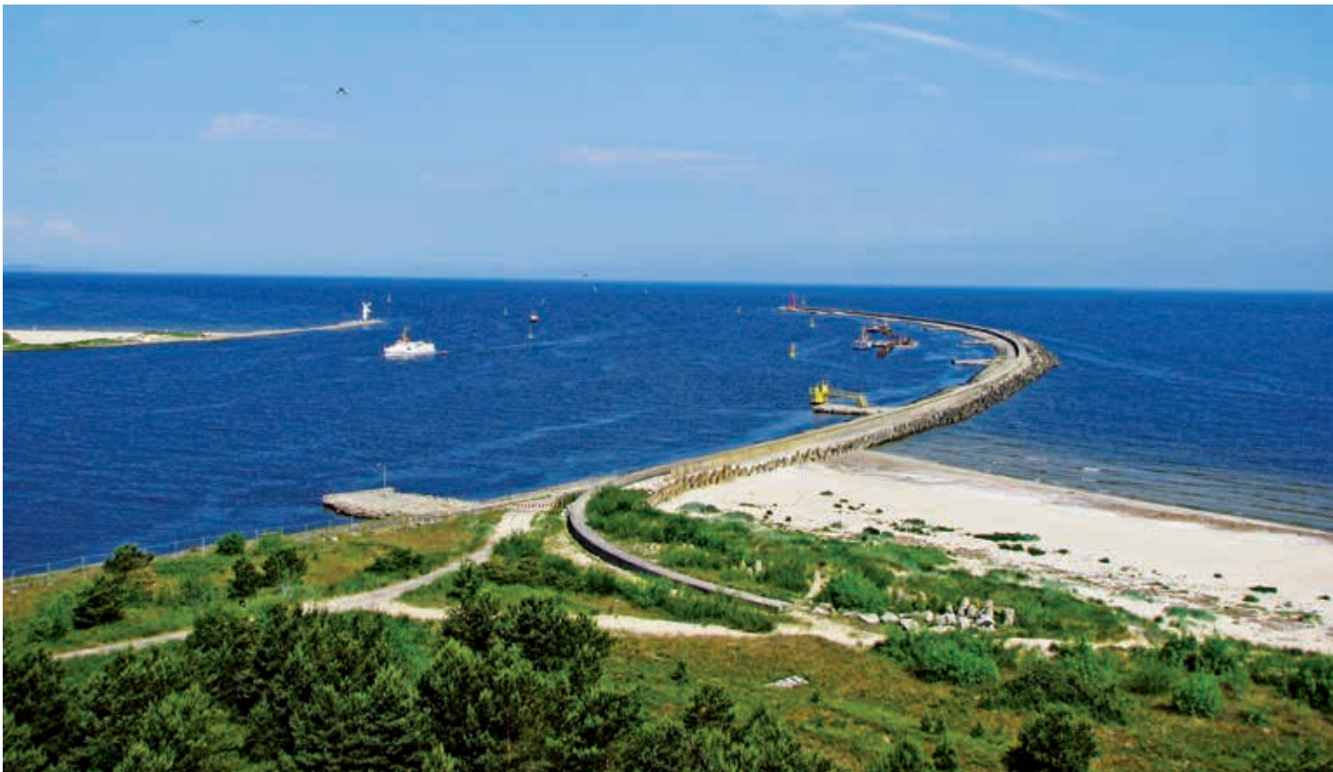
Falochron wschodni w Świnoujściu
