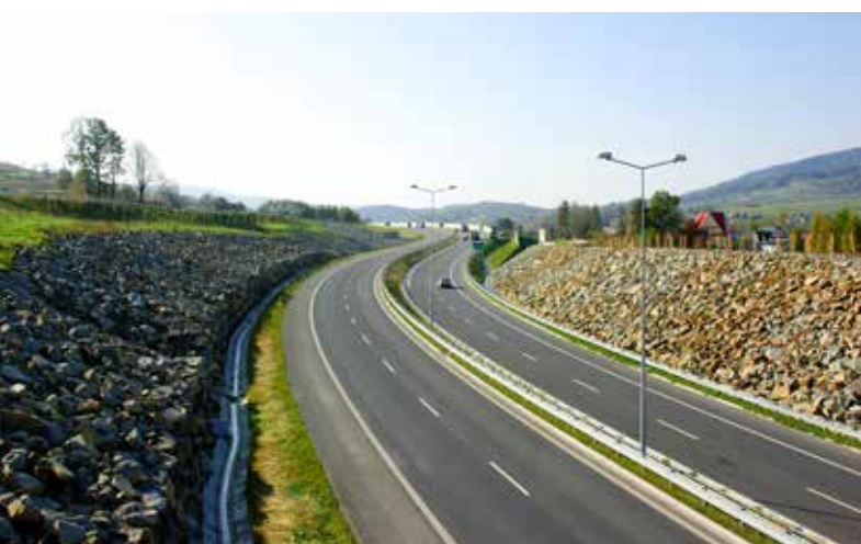
Przykłady zabezpieczania skarp i zboczy, fot. NBI Media, Geobruigg AG
