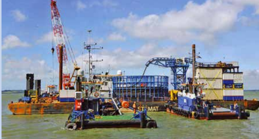
Ryc. 3. Wiertnica z urządzeniami towarzyszącymi, ustawiona na platformie w cieśninie Solent w czasie realizacji drugiej części projektu [3]
