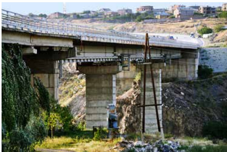
Ryc. 32. Stalowe przęsła mostu na dojeździe do Erywanu
