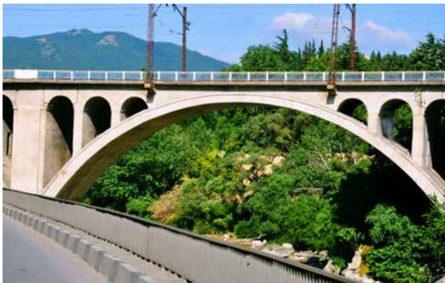
Ryc. 2. Łukowy, betonowy most kolejowy na wyjeździe z Tbilisi w kierunku Mcchety
