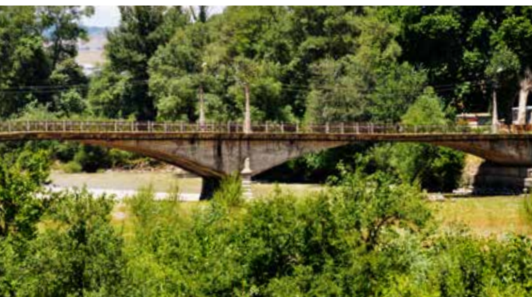
Ryc. 7. Żelbetowy most tukiowy (tuki tarczowe) przez Mtkvari w Gori
