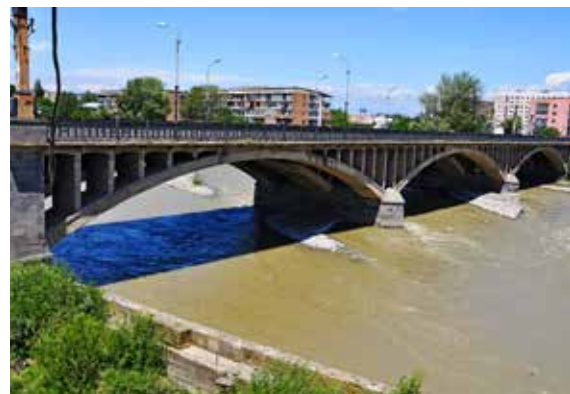
Ryc. 5. Żelbetowy most łukowy przez Mtkvari w Gori
