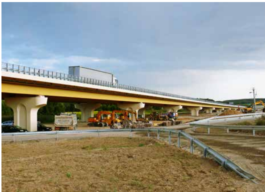
Estakada w miejscowości Jordanowo k. Międzyrzecza posadowiona na fundamencie mikropalowym w ciągu drogi ekspresowej S3. Generalny wykonawca Mota-Engil CE, fot. Titan Polska Sp. z o.o.
