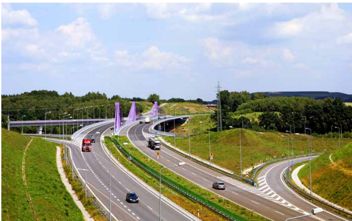
Autostrada A1 – most w Mszanie, fot. M. Prusak
