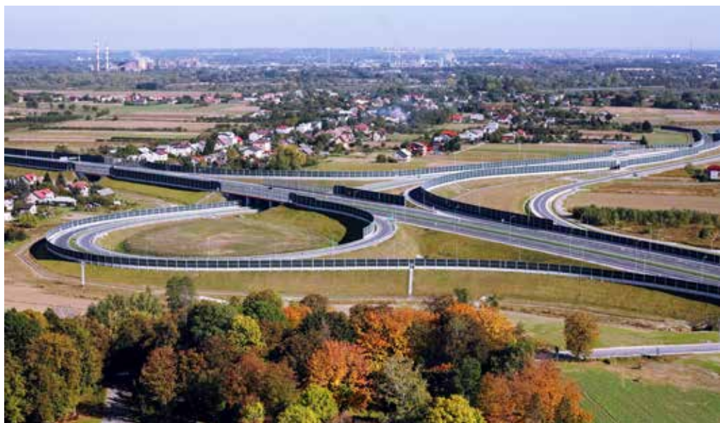
Autostrada A4 Brzesko – Tarnów, fot. Strabag Sp. z o.o.
