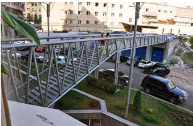
Ryc. 16. Stalowa kładka dla pieszych na zapleczu restauracji
