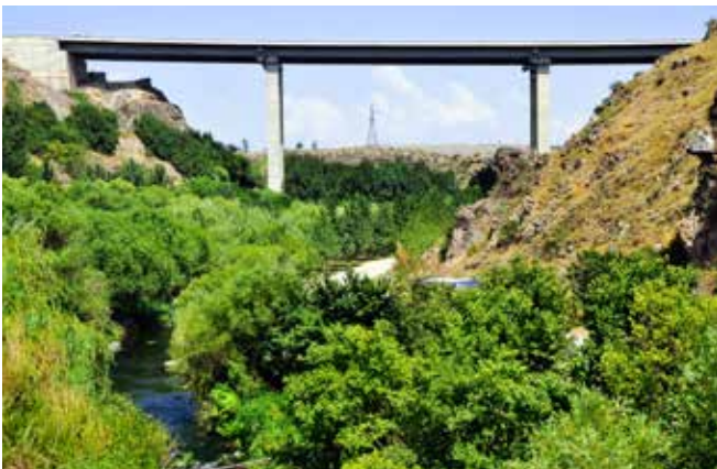
Ryc. 15. Stalowy most autostradowy koło Asztarak
