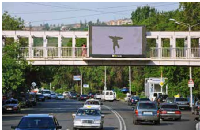
Ryc. 10. Stalowa kładka dla pieszych nad ulicą w Erywaniu
