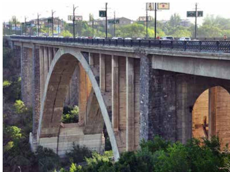
Ryc. 26. Żelbetowy most łukowy w centrum Erywania
