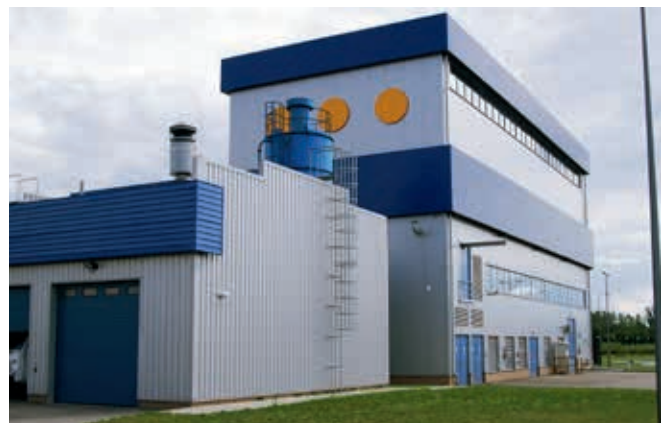
Stacja Termicznej Utylizacji Osadów Ściekowych należąca do Oczyszczalni Ścieków w Sitkówce k. Kielc, fot. Wodociągi Kieleckie Sp. z o.o.
